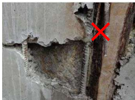
图6.25 混凝土孔洞
