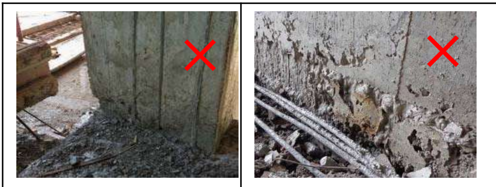
图6.27 混凝土烂根
