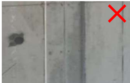
图6.18 铝模企口混凝土表面光滑
