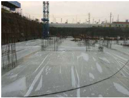
图6.16 混凝土覆盖、养护
