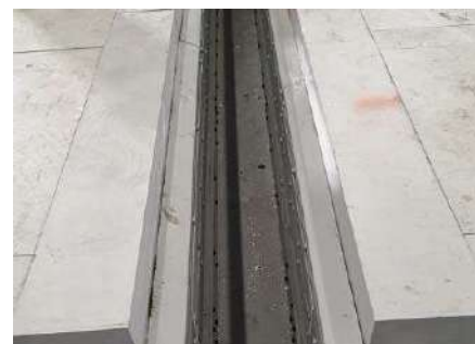
图6.20 表面磨砂处理
