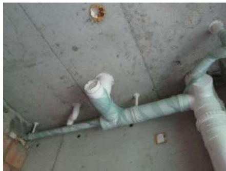
图6.45 安装立管去除塑料保护膜
