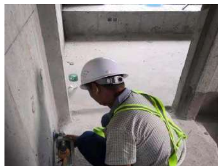
图6.21 墙面打磨
