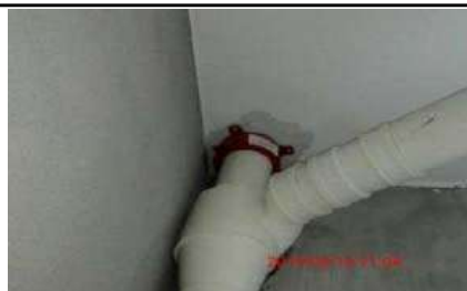
图6.41 管边渗漏
