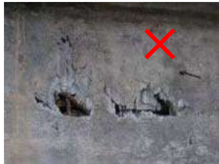
图6.25 混凝土孔洞
