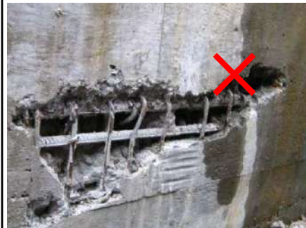
图6.26 混凝土漏筋
