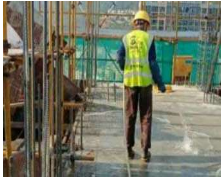
图6.16 混凝土覆盖、养护
