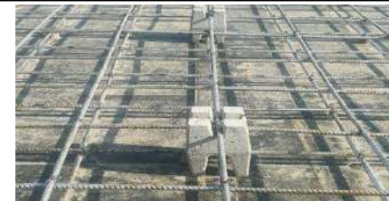
图6.4 定型混凝土马镫
