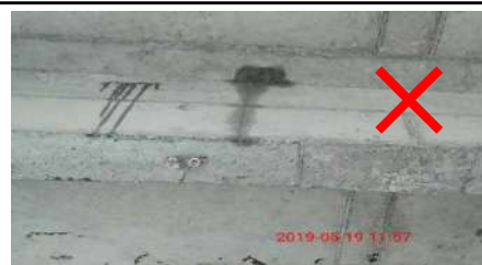
图6.31 梁、板交接处渗漏
