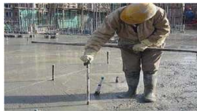
图6.3 拉线测量标高
