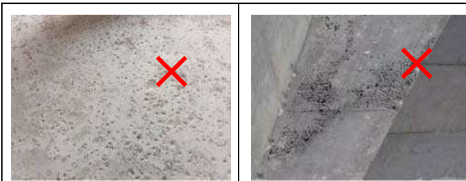
图6.24 混凝土麻面
