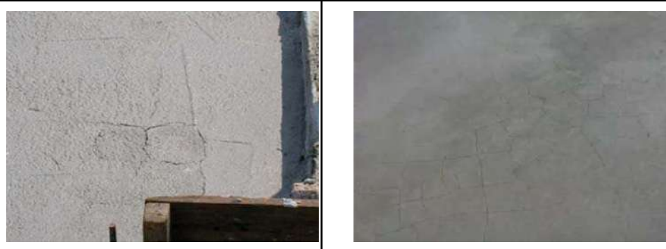
图6.51 混凝土龟裂
