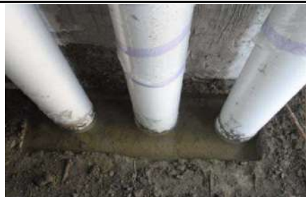
图6.43 分层吊洞并闭水
