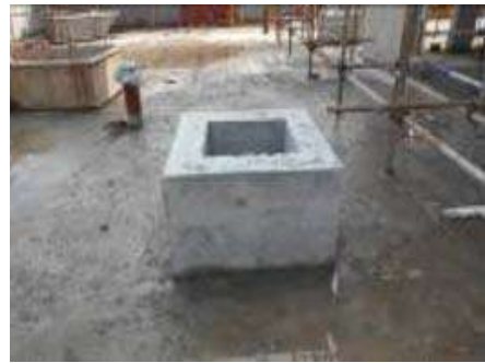
图6.49 烟道翻边随结构一次浇筑
