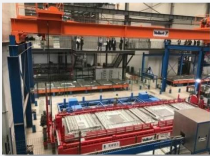
钢筋、混凝土、模板工厂化生产
