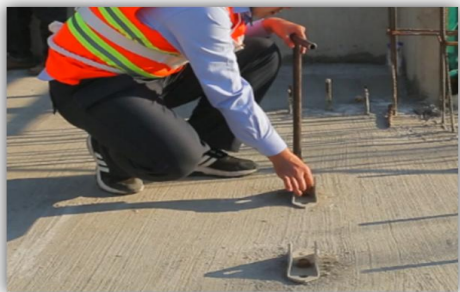
标高测量、垫片固定、标高复测
