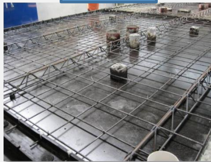
管道洞口预埋
