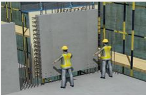
墙板安装定位示意图
