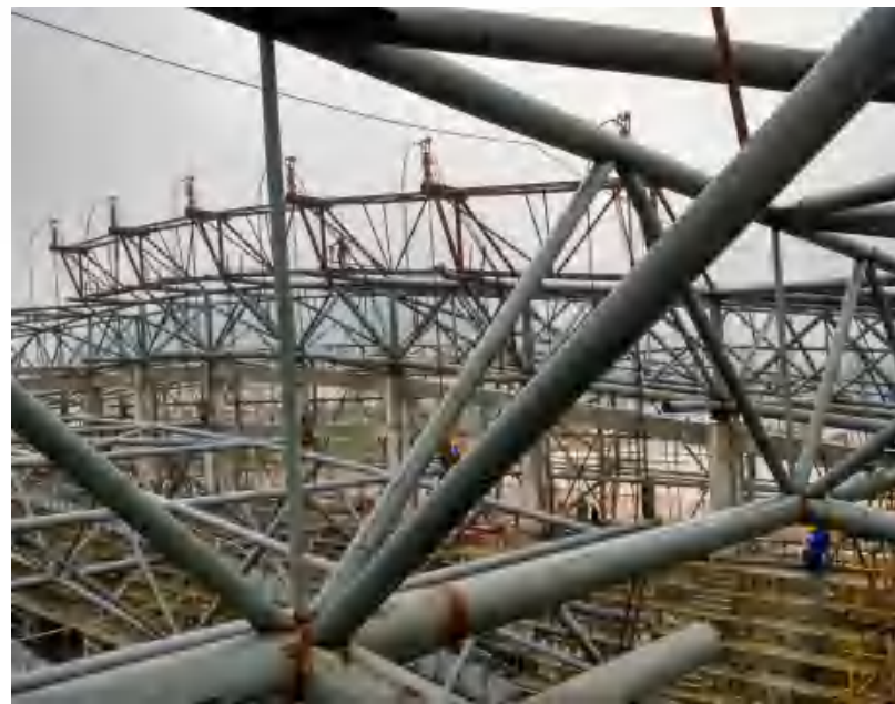
周边支承双向交叉空间钢桁架结构多高差场地地下施工工法
