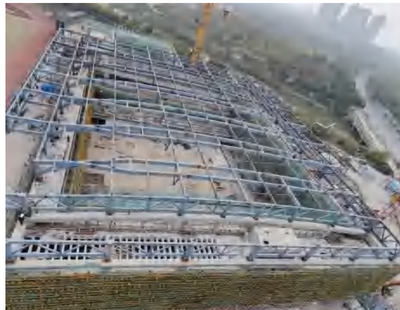
大跨度张弦梁与桁架悬挑组合屋架施工工法
