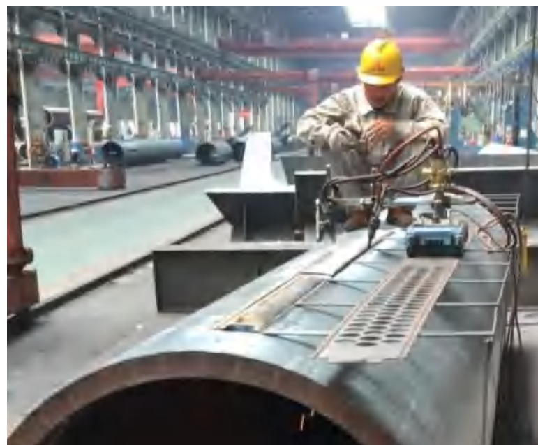
贯穿插板的大直径钢圆管柱加工工法
