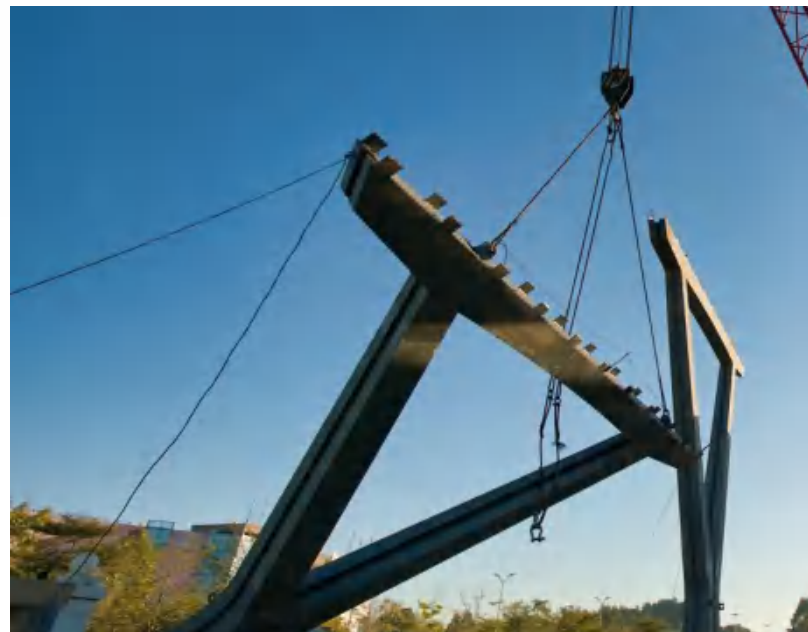
超大箱型Y型变截面钢立柱加工及施工工法
