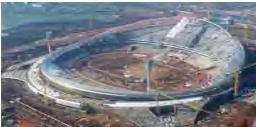
应用实例1：海口五源河体育场钢结构工程
