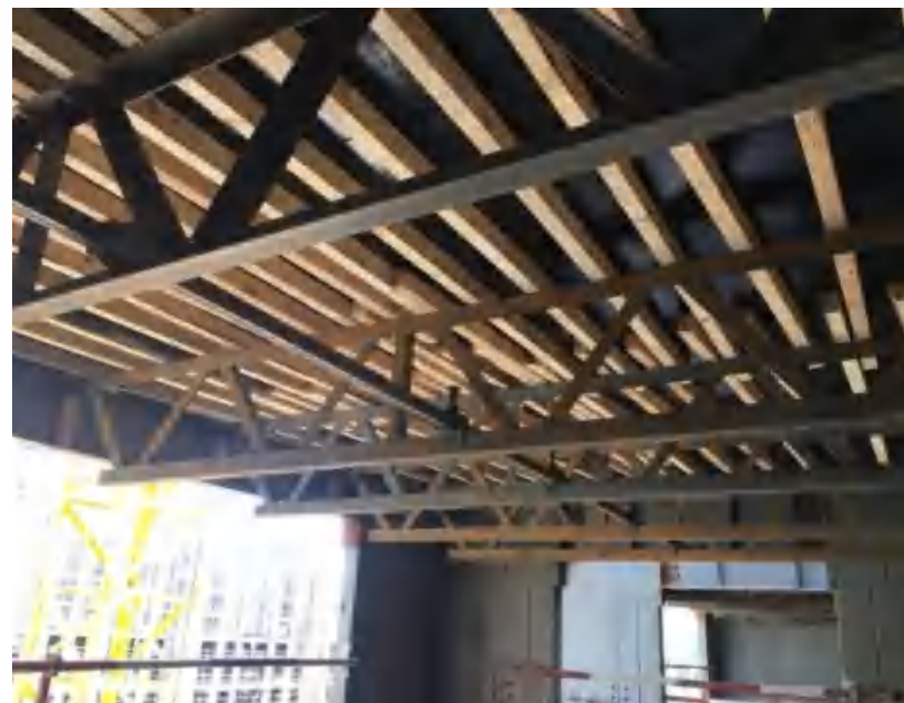
钢管束住宅楼板角钢桁架免竖向支撑施工工法
