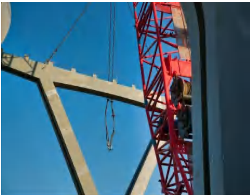
超大箱型Y型变截面钢立柱加工及施工工法
