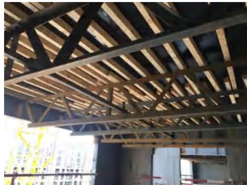
钢管束住宅楼板角钢桁架免竖向支撑施工工法
