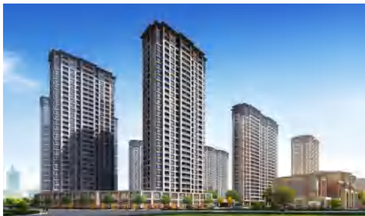
应用实例1：杭大江东储出【2017】1号地块住宅兼服务设施用地项目 钢结构工程（二期）31#、35#、39#楼
