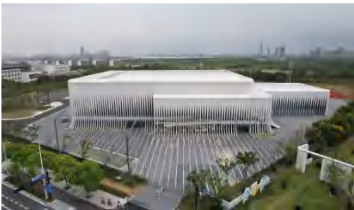
应用实例：浙江师范大学萧山校区体育场馆（亚运手球比赛馆）建设工程
