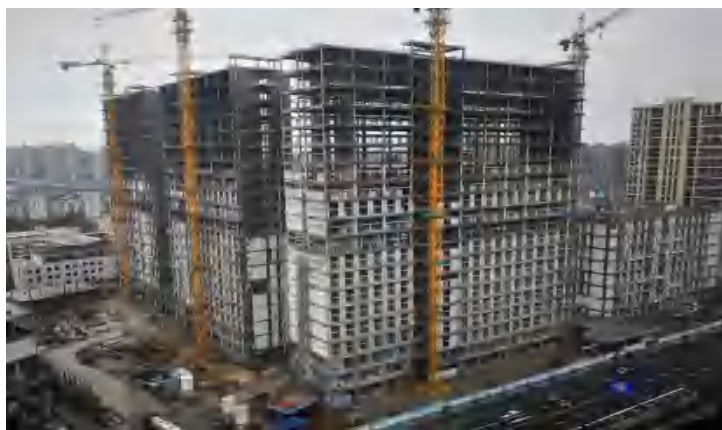
应用实例1：杭政储出[2017]5号地块商业商务用房项目（一期）
