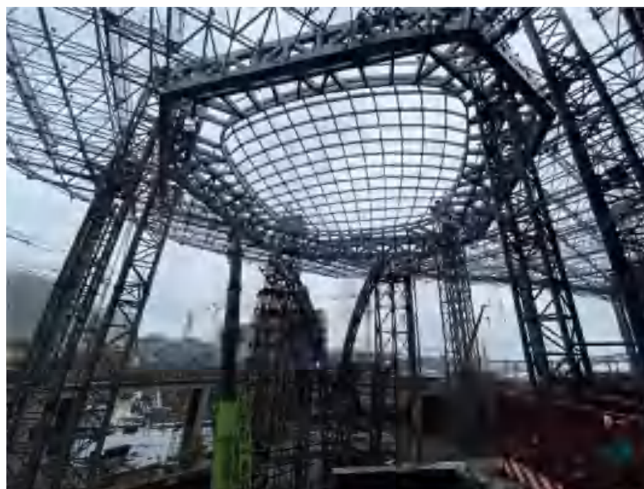
“荷花谷”异形双曲钢结构倒序安装施工工法
