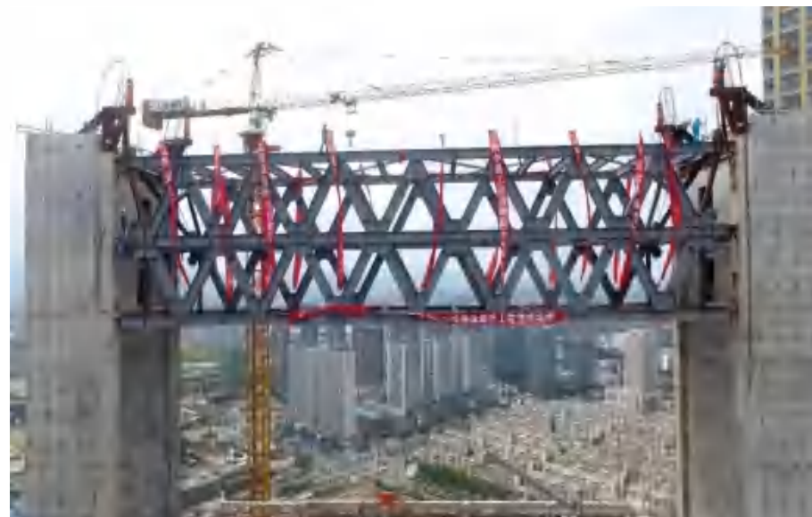
转换钢桁架原位液压同步整体提升工法
