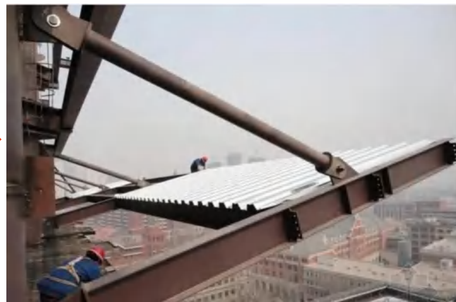
超大悬挑钢结构可调式拉杆施工工法
