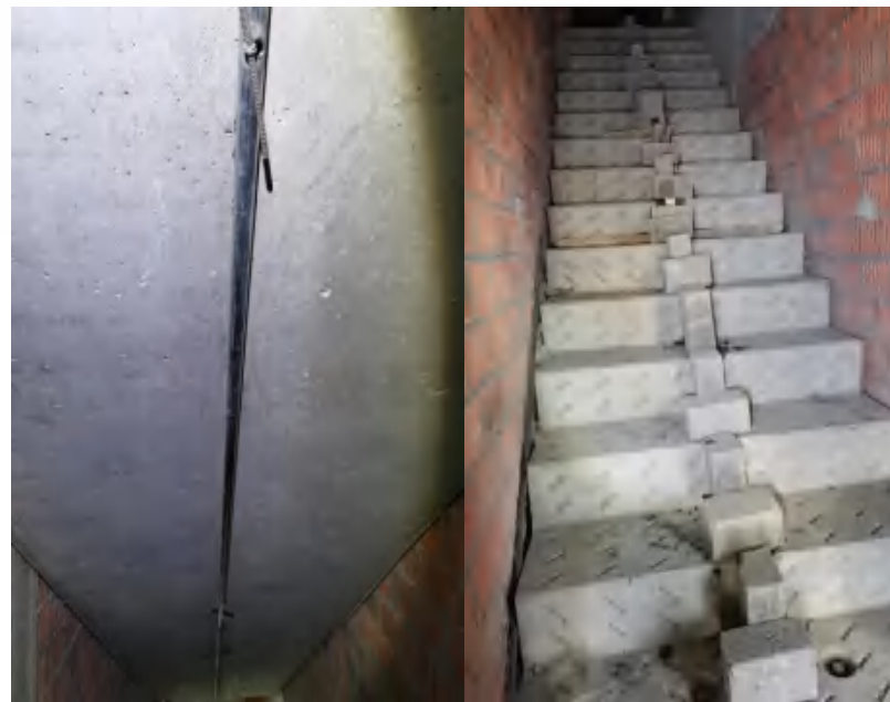
PC楼梯纵向拼缝灌浆施工工法
