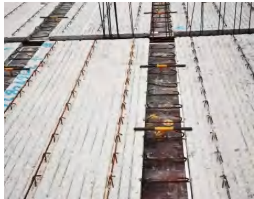
装配式混凝土结构叠合板接缝防漏浆施工工法
