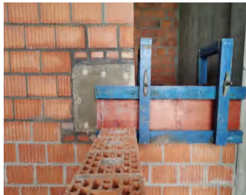
窗侧U型预制构件施工工法
