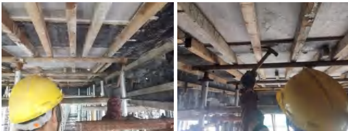
采用调整可调顶托和三角形木楔处理缝隙
