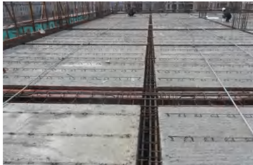
装配式混凝土结构叠合板接缝防漏浆施工工法
