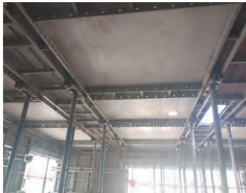
装配式高层住宅铝模+叠合板一体化支撑施工工法
