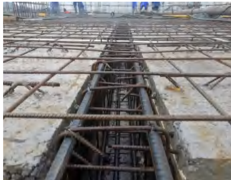
装配式叠合板与大截面框架梁组合施工工法
