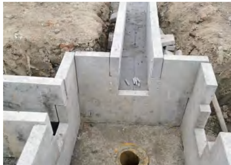
承插装配式胎膜施工工法
