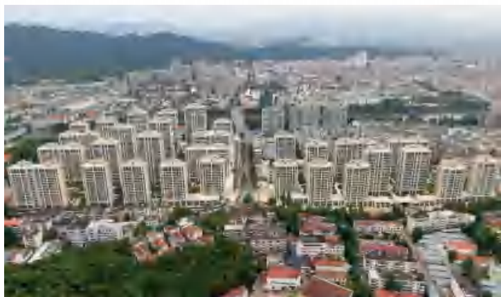
应用实例2：武义县城区棚户区改造溪南区块安置房建设项目（标段一）
