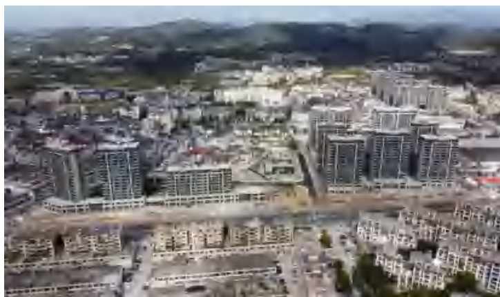
应用实例1：武义县桐琴镇桐琴棚户区改造工程1#、2#和3#地块
