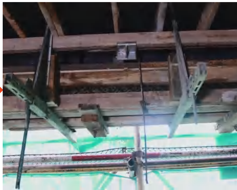
装配式混凝土结构叠合板接缝防漏浆施工工法
