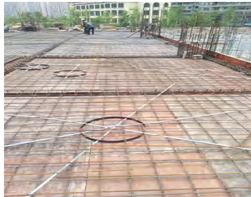
建筑预埋电气导管多管叠合施工工法
