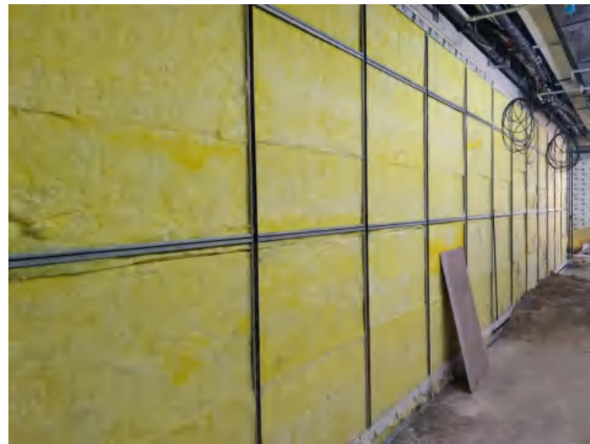
可拆卸无损承插结构装配式墙板施工工法
