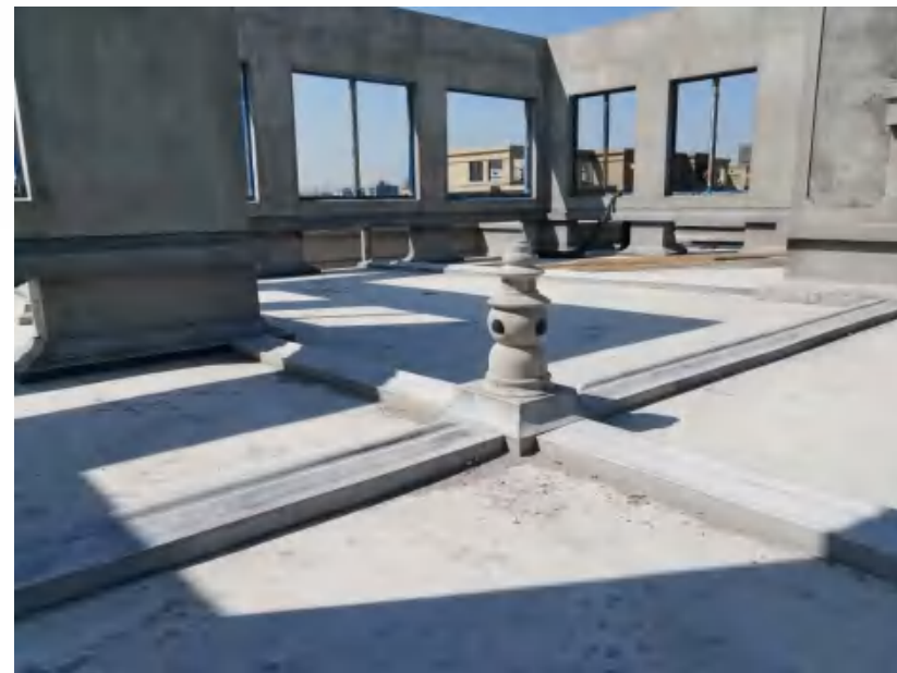
屋面预制混凝土透气孔施工工法
