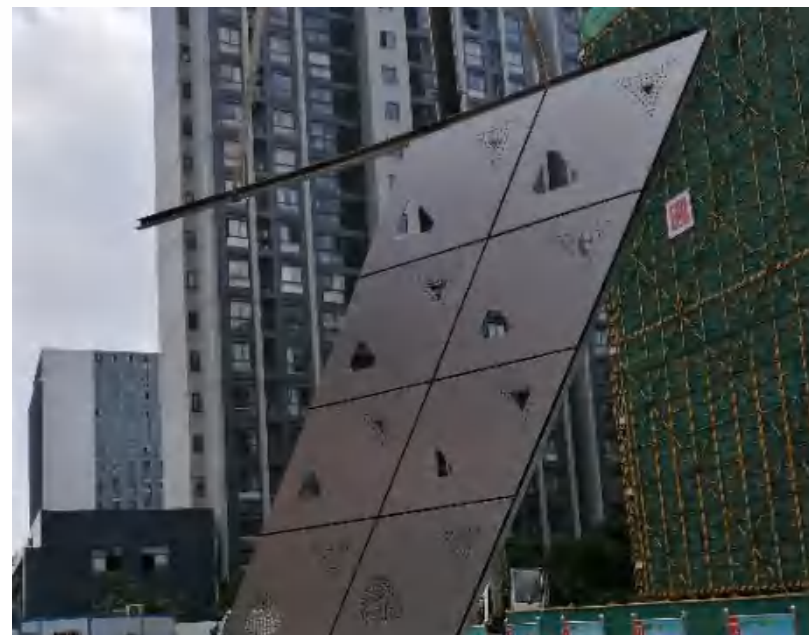
装配式幕墙板块面内或面外偏心状态安装施工工法
