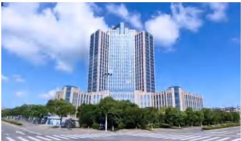
应用实例2：舟山锦舟宝盛大酒店装饰装修改造工程
