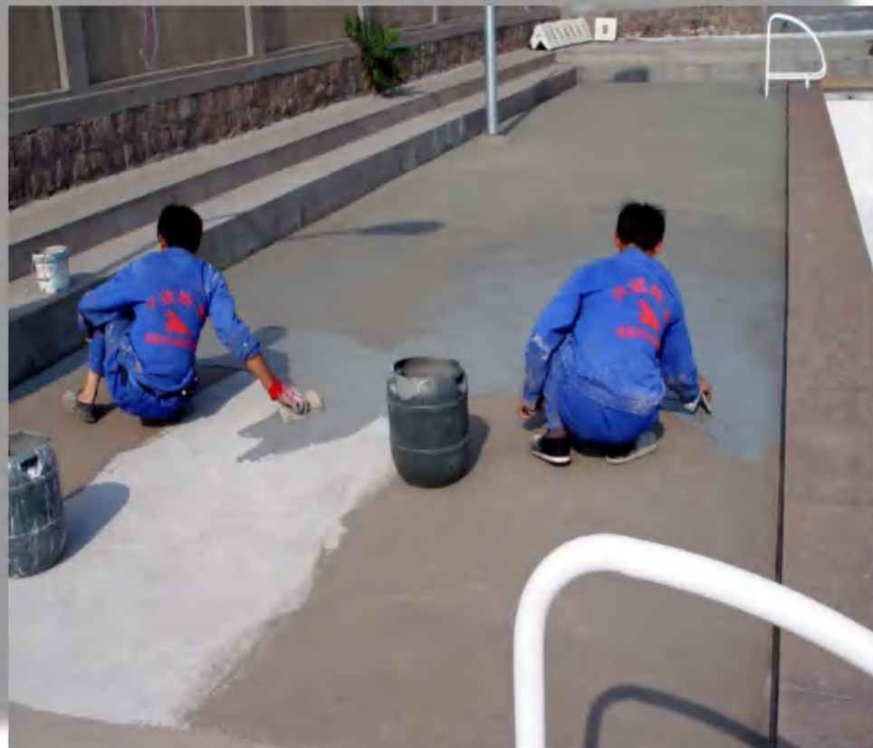
水泥砂浆防水层的分层交叉涂抹
