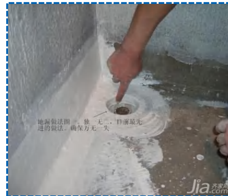
地漏涂膜防水
