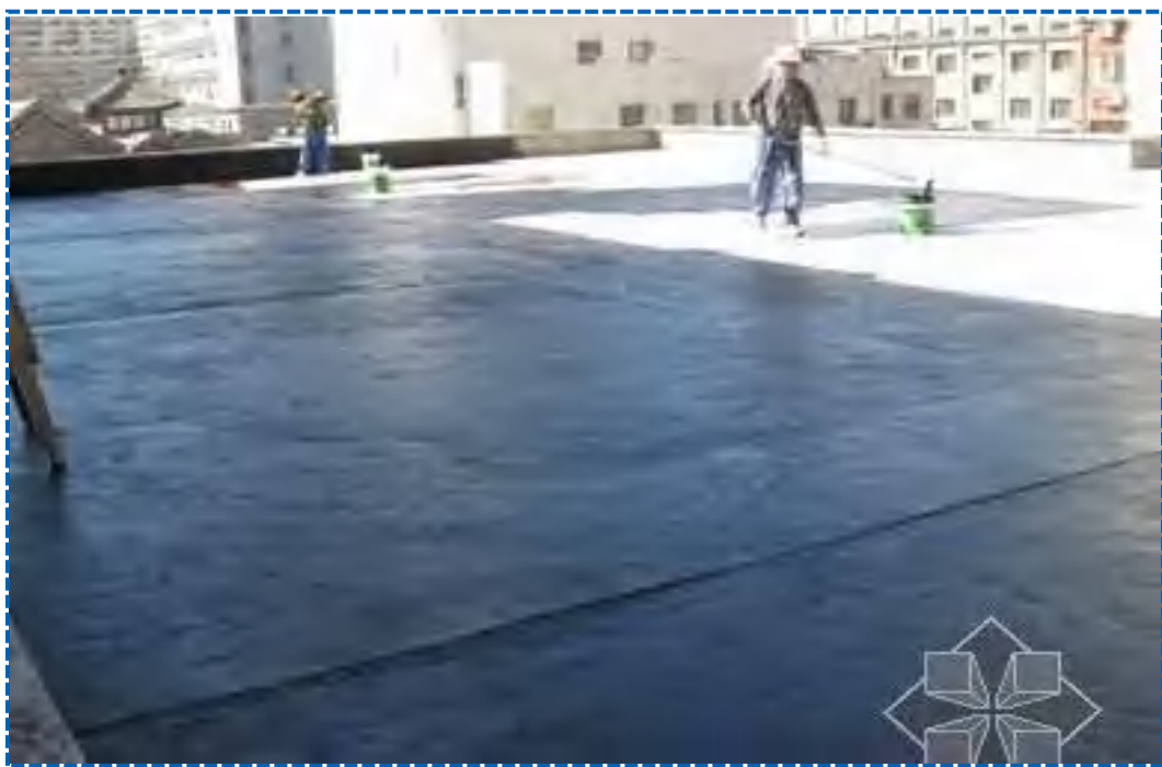
冷底子油施工
