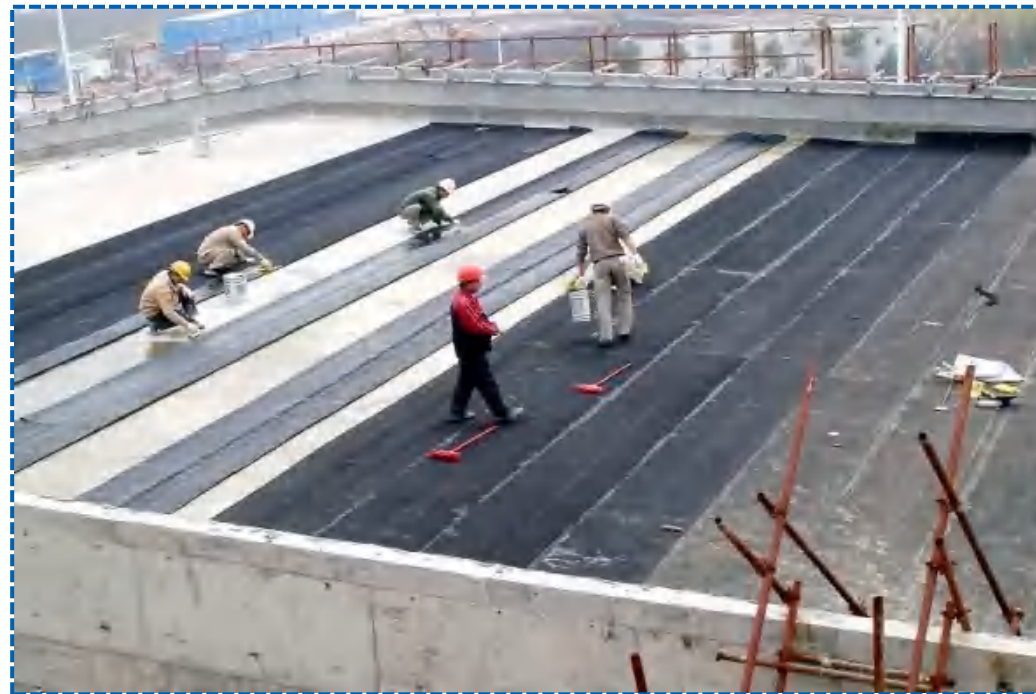
冷粘法施工
