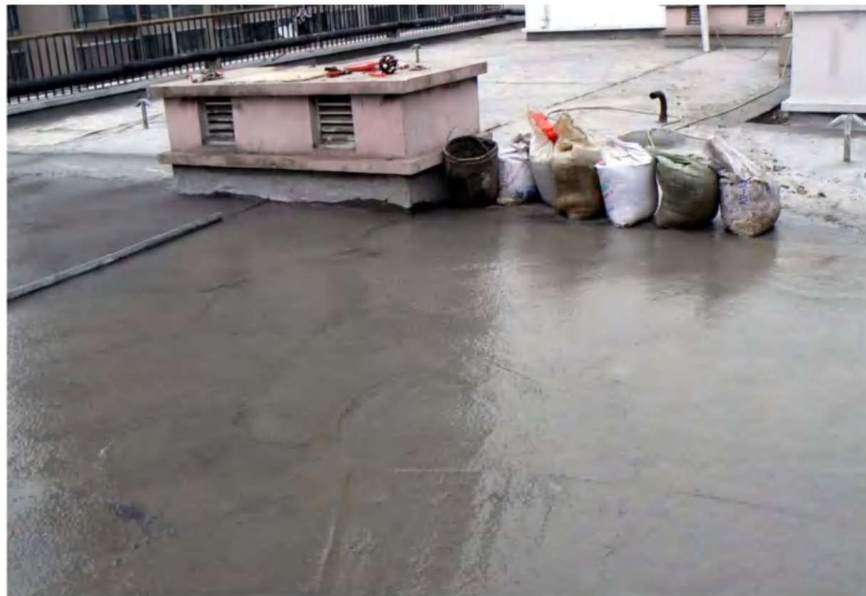
细石砼防水层施工
