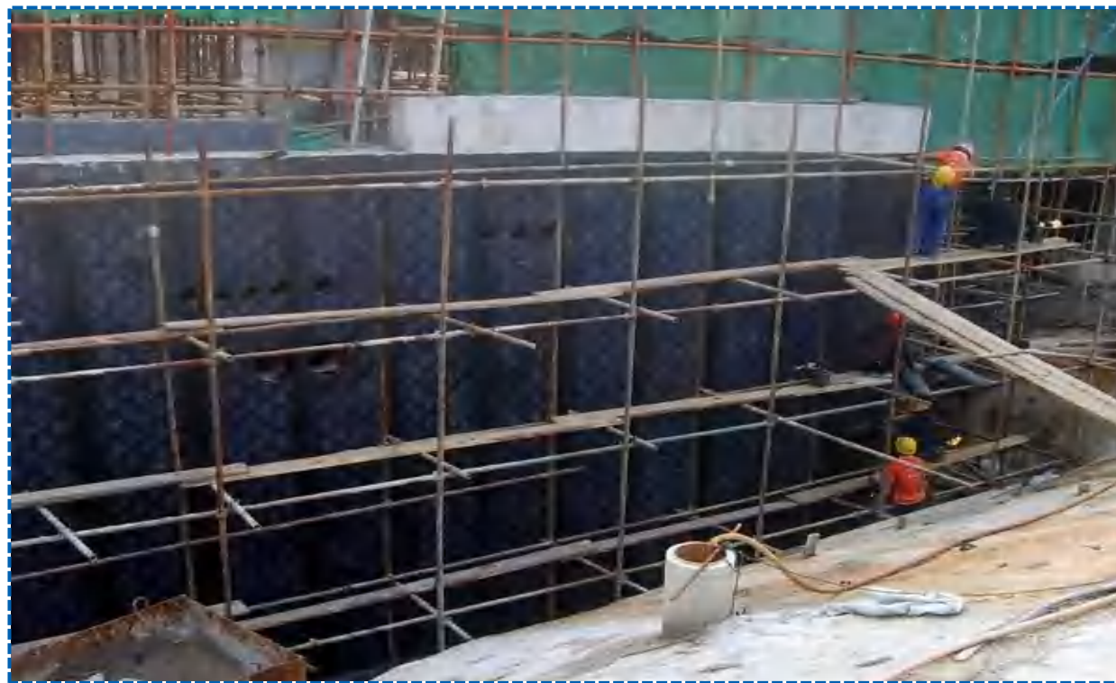
地下室外防外贴法施工
