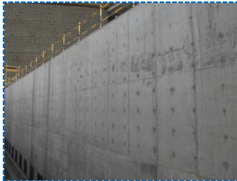
地下室防水混凝土
