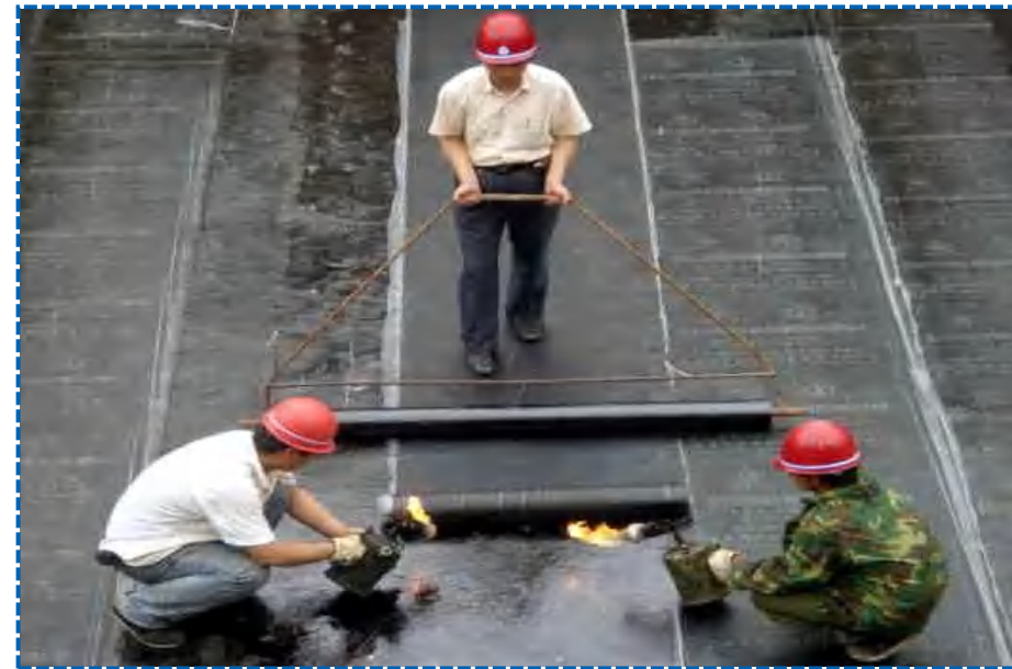
热熔法施工
