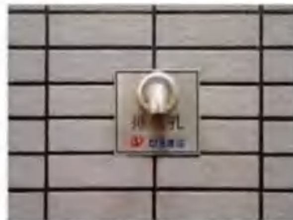
排气管设置在女儿墙上
