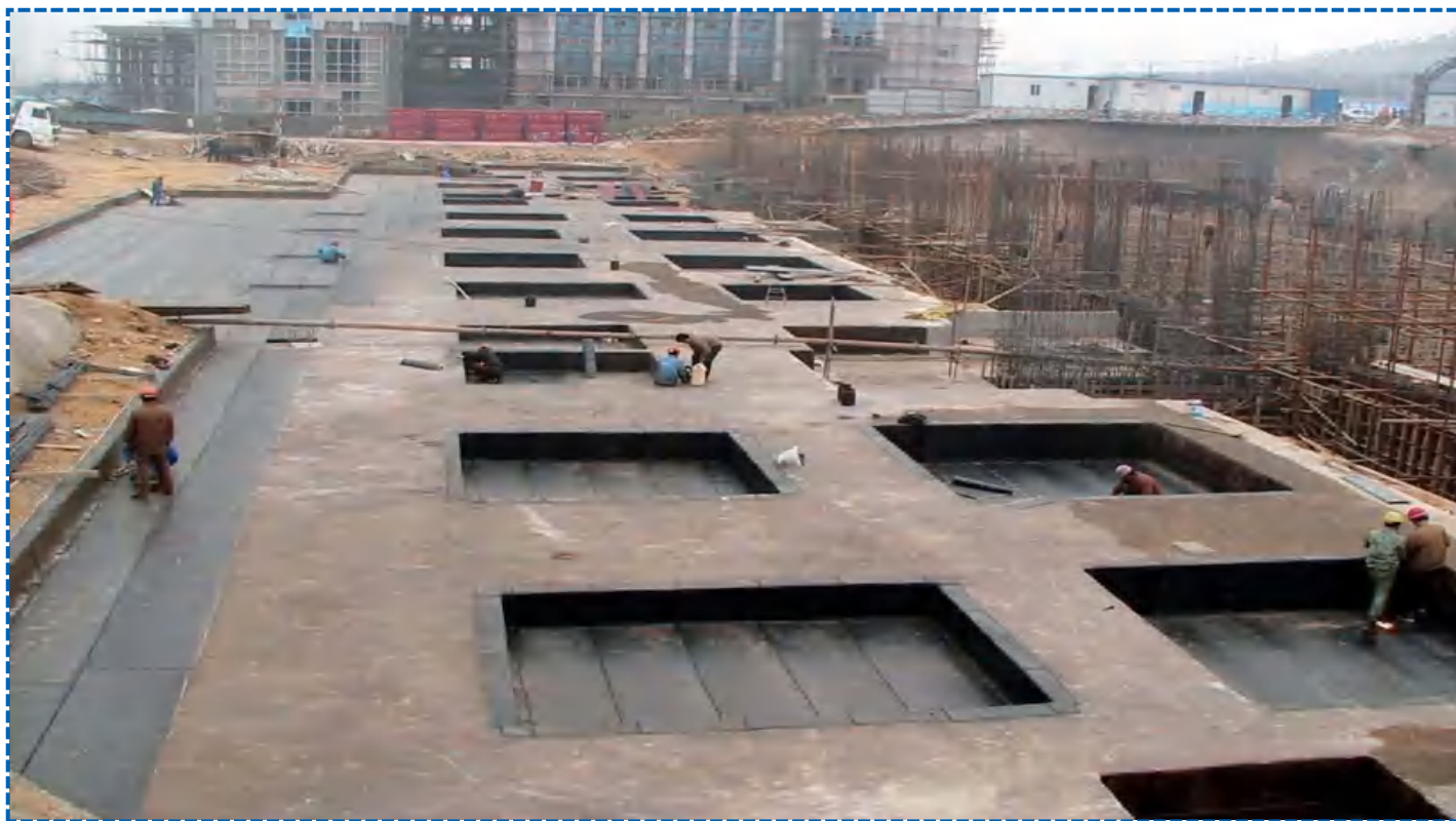
地下室外防内贴法施工全景
