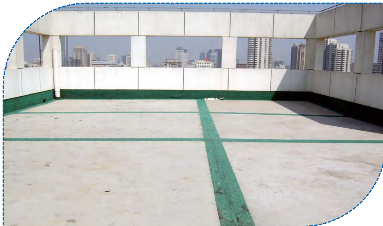
屋面分格缝的面层处理
