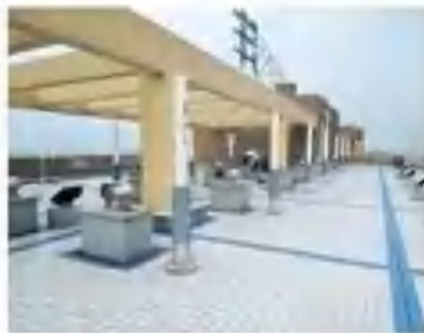
通风管位置优化调整 豆丁施工
