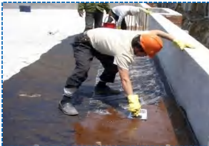
手工抹压涂刷
