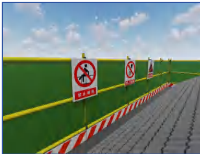
图6-25 斜屋面临边防护（1）
