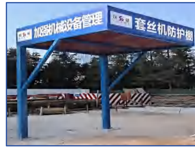
图6-31 小型机械防护棚 (4)
