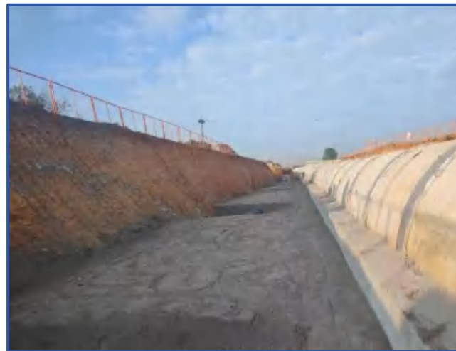
图9-23 沟槽回填
