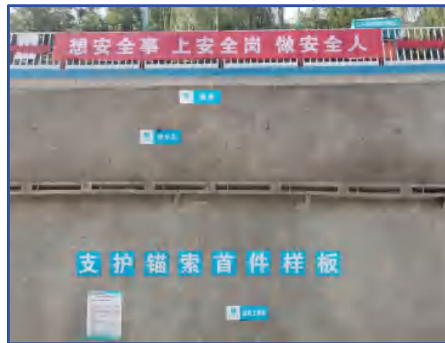
图1-10 基坑桩锚支护 (3)
