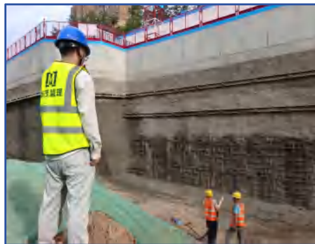
图1-3 监理单位基坑巡查
