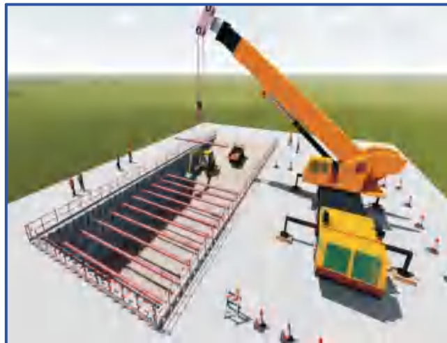
图1-15 钢支撑安装
