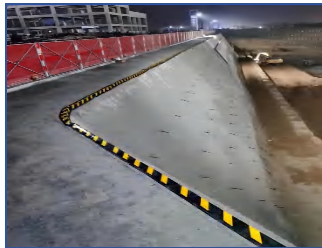
图1-7 土钉墙支护（2）
