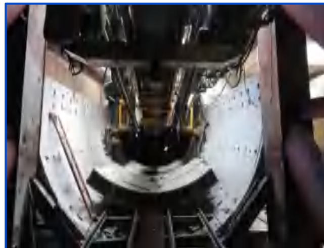
图9-120 负环管片拼装
