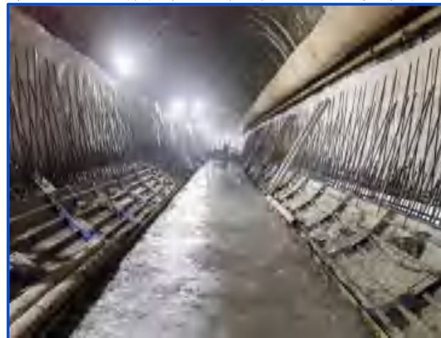
图9-104 暗挖隧道拱墙混凝土浇筑施工
