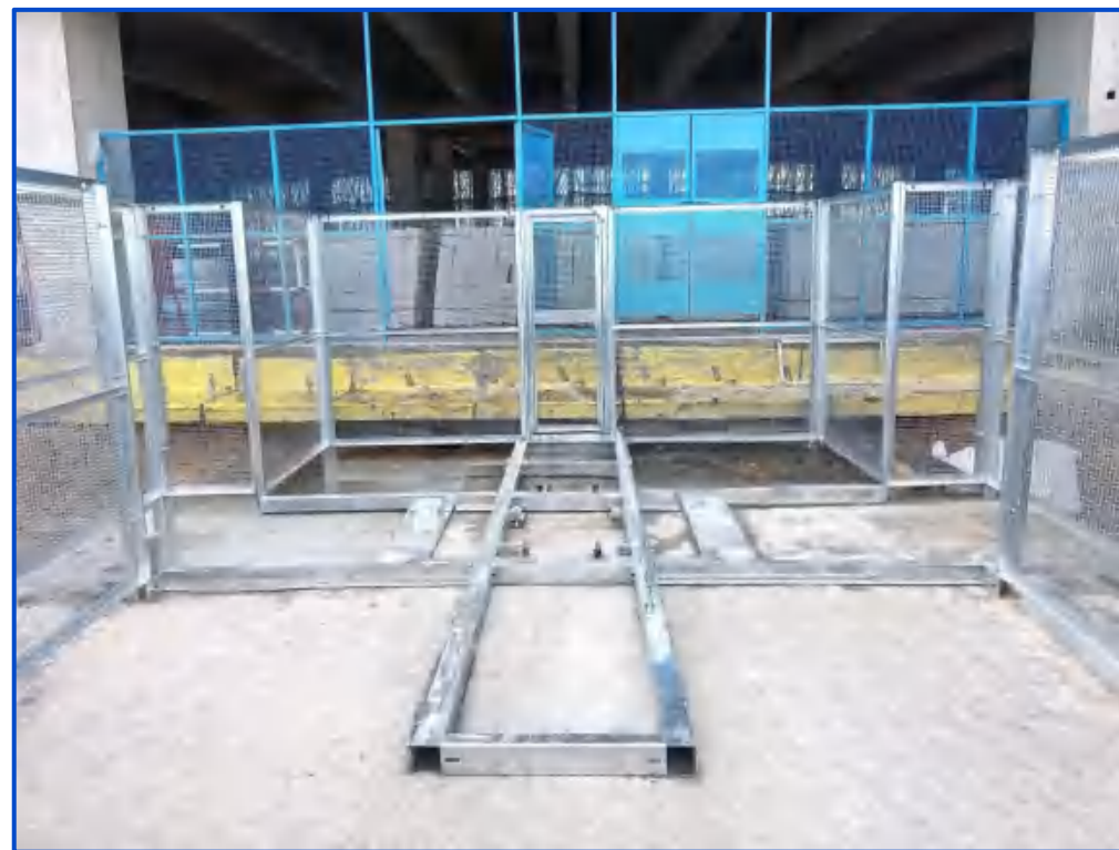
图5-46 施工升降机基础
