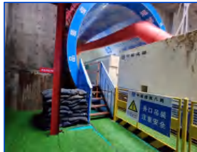
图9-111 隧道口人行通道
