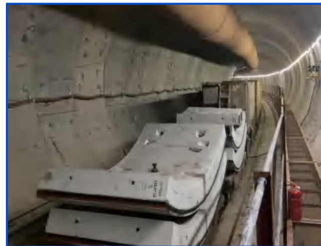
图9-131 管片洞内水平运输
