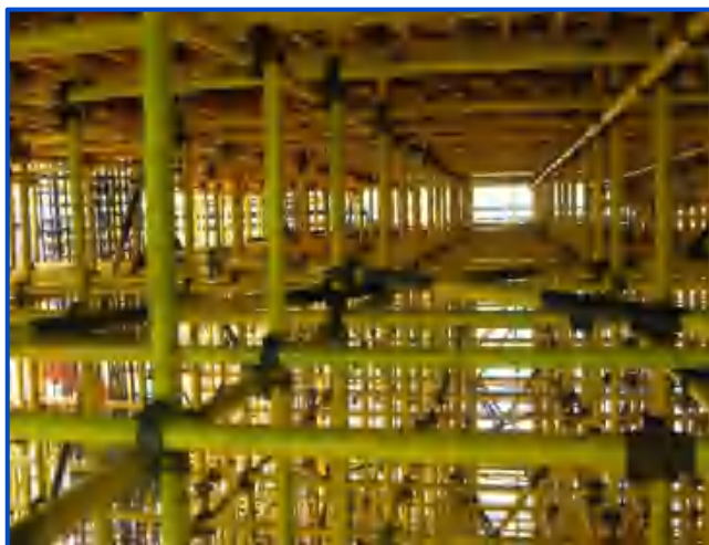
图3-20 扣件式钢管水平剪刀撑
