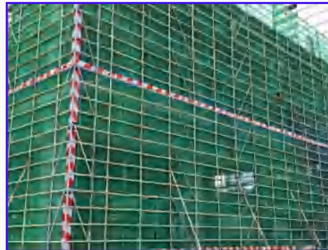
图2-10 端部、转角处搭设（2）
