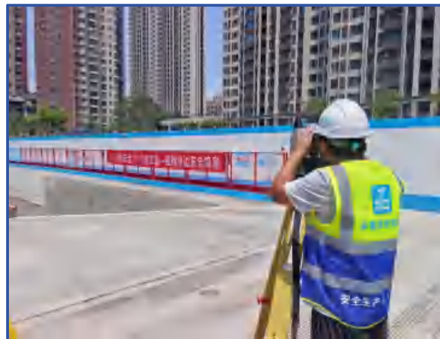
图1-2 施工单位基坑巡查
