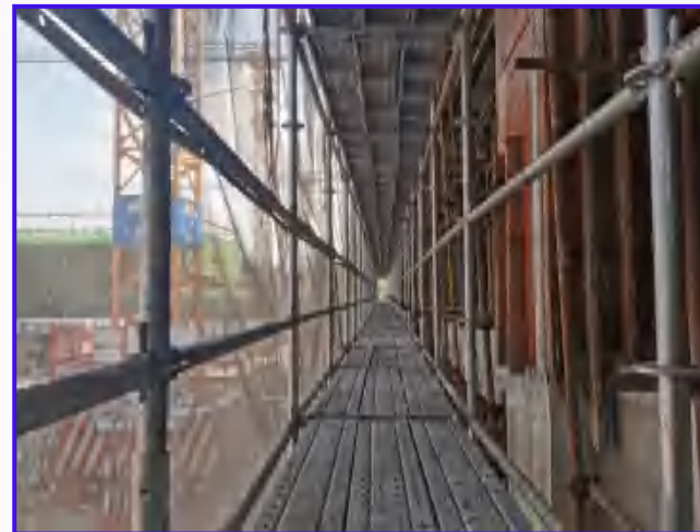
图2-14 脚手架满铺脚手板（2）
