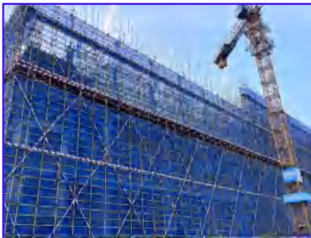
图2-8 高度24米及以上剪刀撑设置
