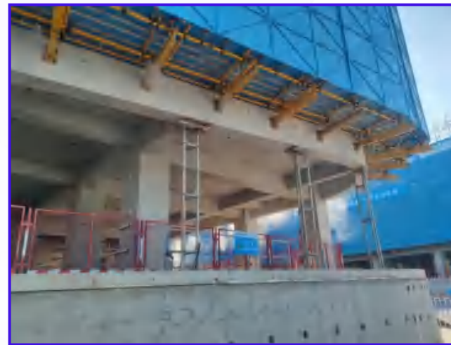
图2-28 脚手架架体封闭（2）
