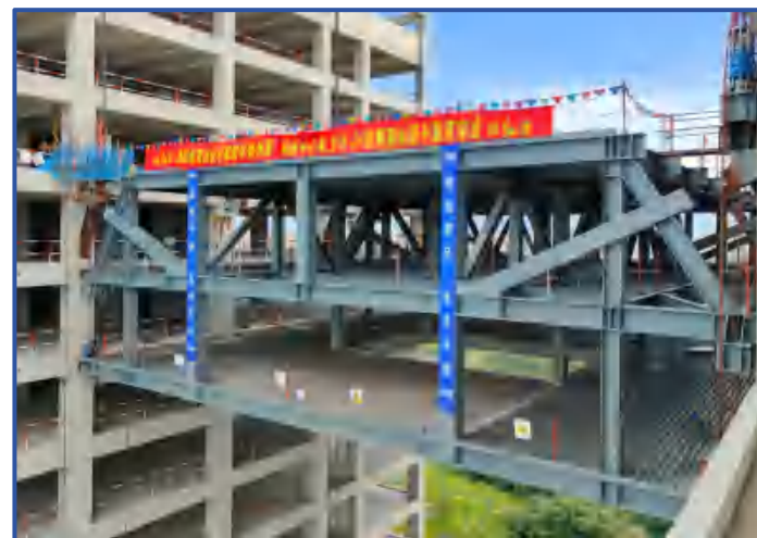
图7-9 连廊整体提升施工
