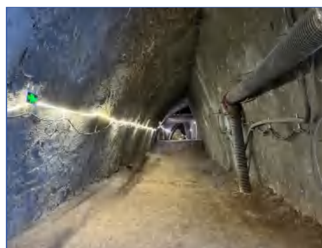
图9-80 隧道支风管
