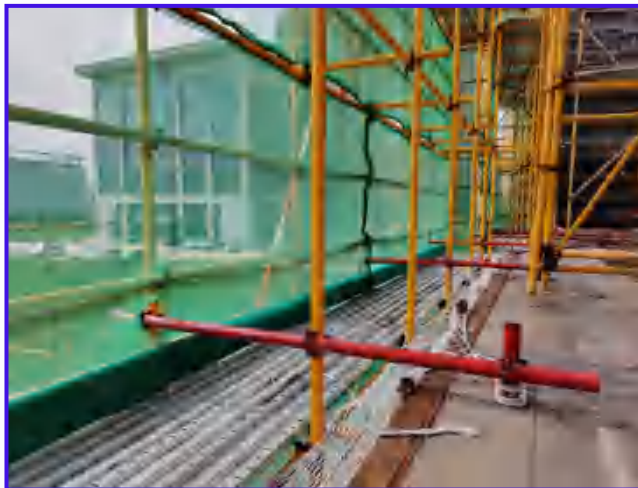
图2-4 脚手架连墙件设置 (1)
