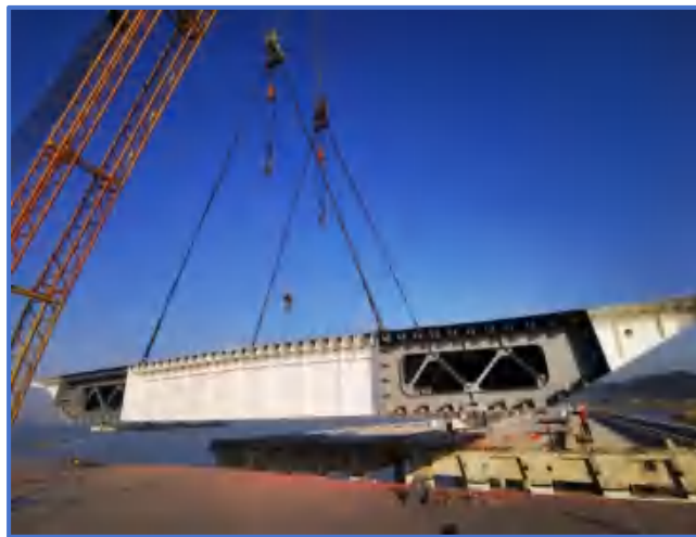
图9-45 双机吊装作业
