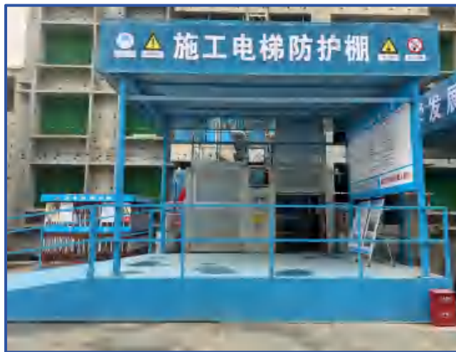
图6-27 施工升降机防护棚（1）
