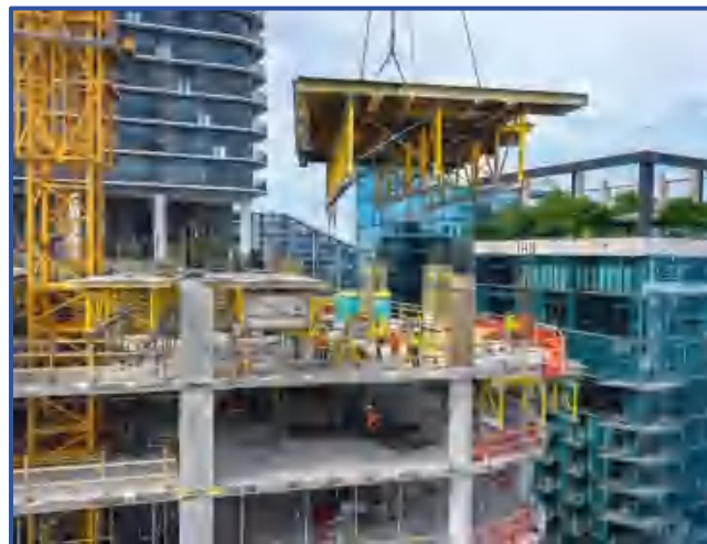
图3-41 飞模拆除示意图
