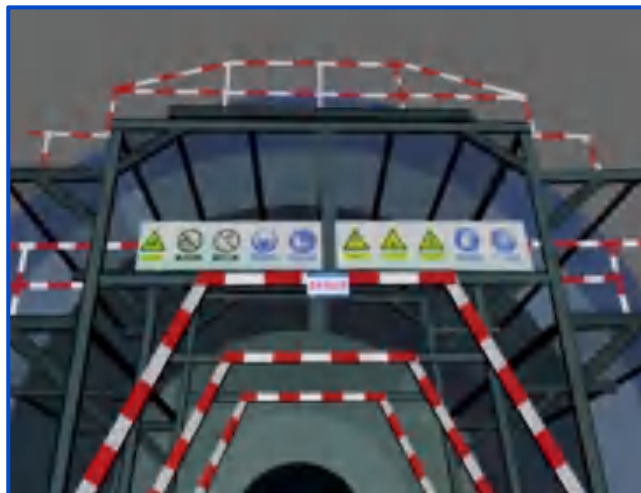
图9-89 隧道方管作业台架
