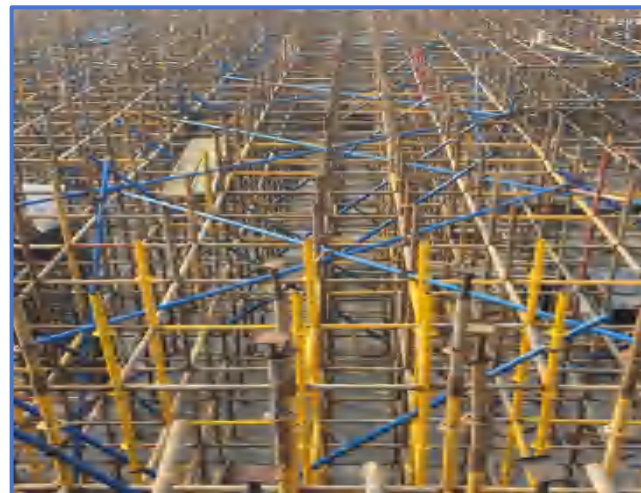
图3-31 承插型轮扣式支撑剪刀撑设置
