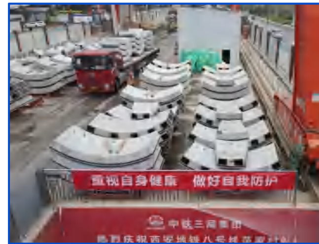
图9-107 盾构管片堆场
