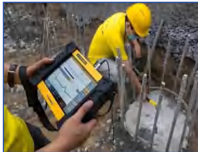
图1-11 桩身完整性检测
