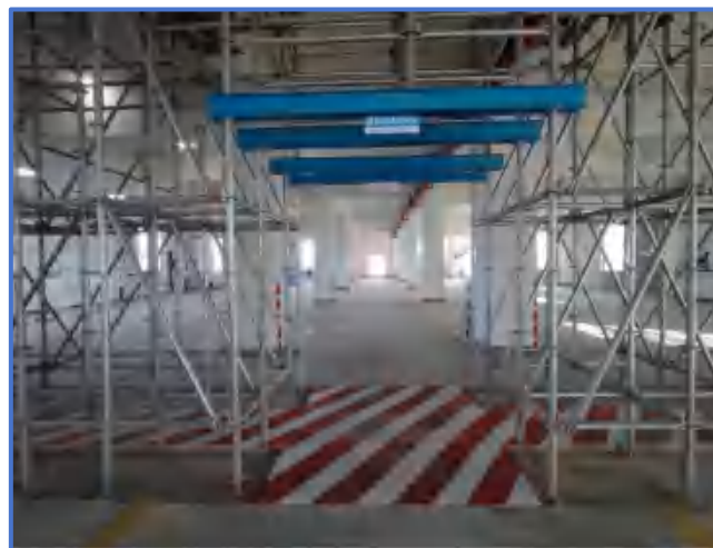
图3-44 后浇带过人通道设置
