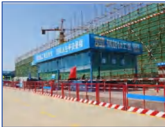
图6-28 半封闭式钢筋加工车间
