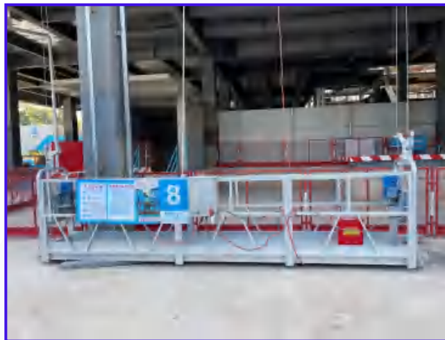
图2-41 吊篮操作平台
