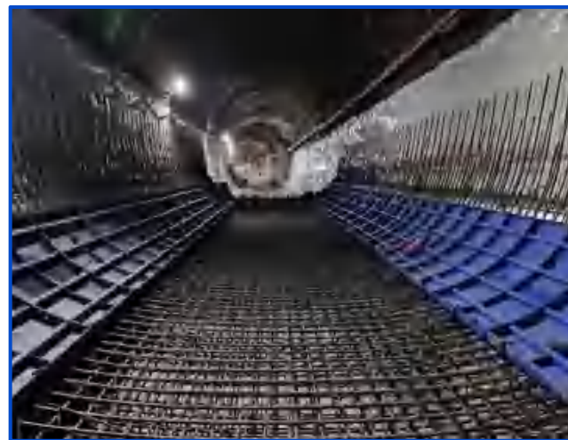
图9-101 暗挖隧道仰拱施工
