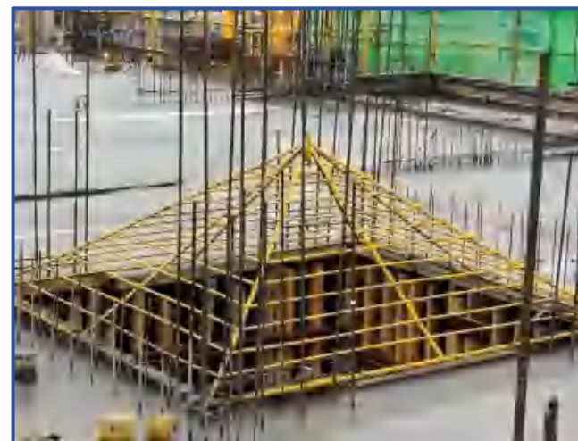
图6-17 电梯井施工层水平防护
