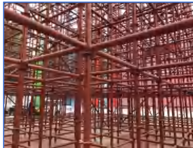
图3-30 承插型轮扣式支撑剪刀撑设置
