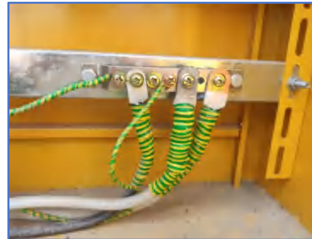
图4-20 PE线接线端子
