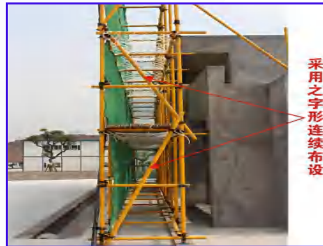
图2-9 横向斜撑设置
