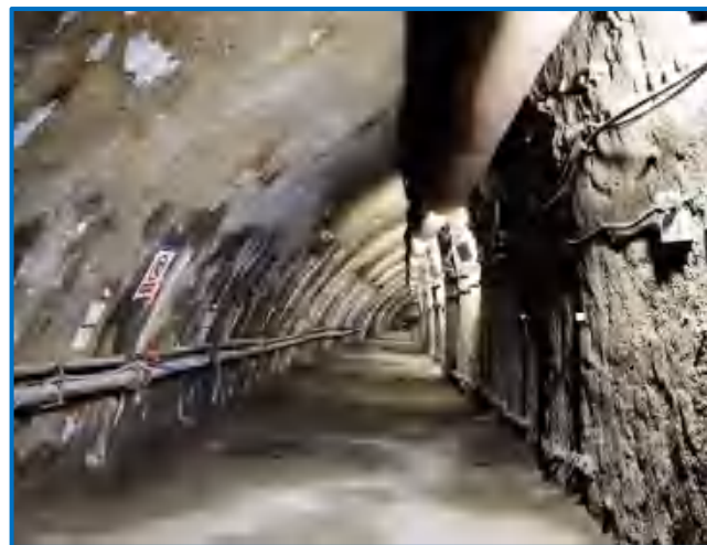
图9-79 隧道支风管
