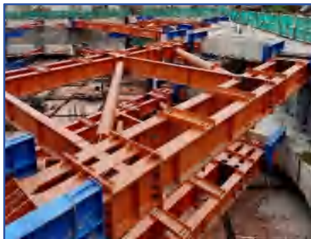
图1-16 钢支撑支护（2）
