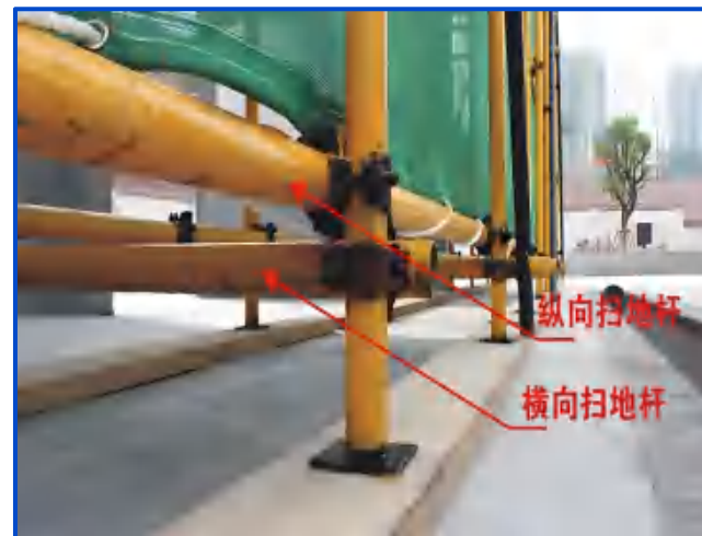
图3-16 扣件式钢管支撑架水平杆
