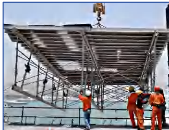
图3-40 飞模安装示意图
