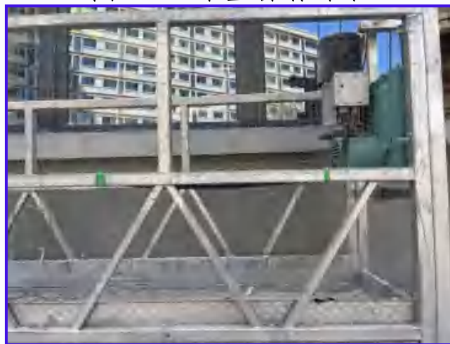
图2-42 吊篮外部设置钢丝网
