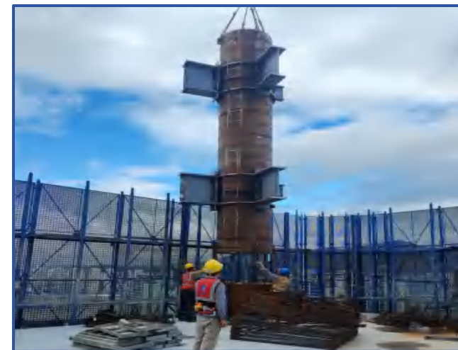
图7-3 钢柱吊装施工
