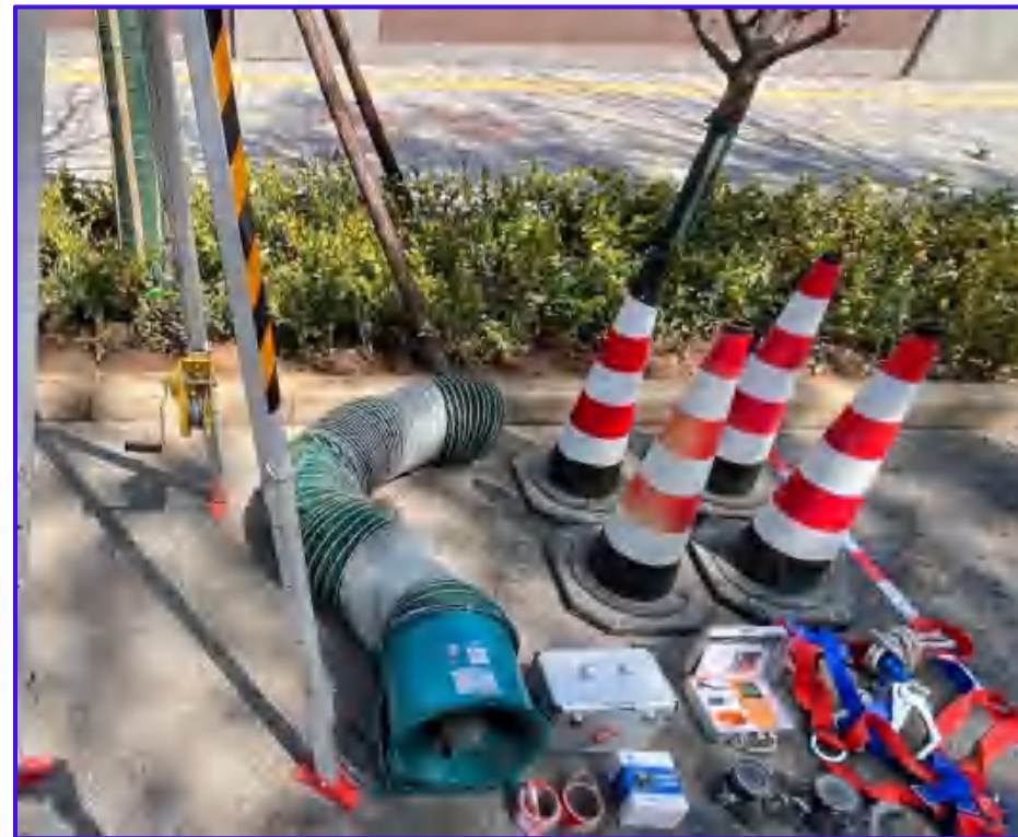
图8-19 完工进行清点人员、工器具、物料等
