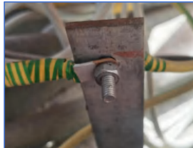
图4-29 接地端子螺栓、铜鼻
