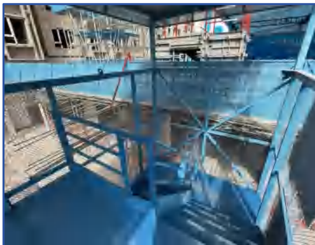
图1-24 基坑人行通道爬梯扶手
