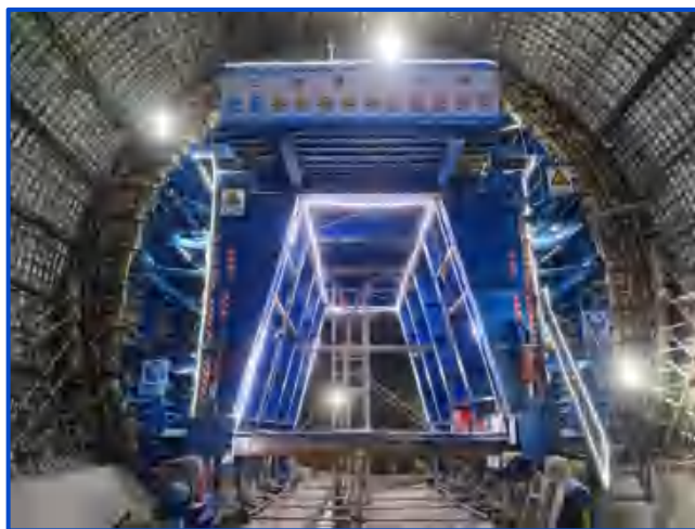
图9-91 二衬台车设置防护、标识
