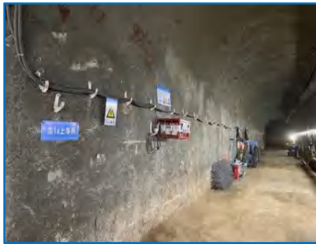
图9-81 隧道电缆敷设
