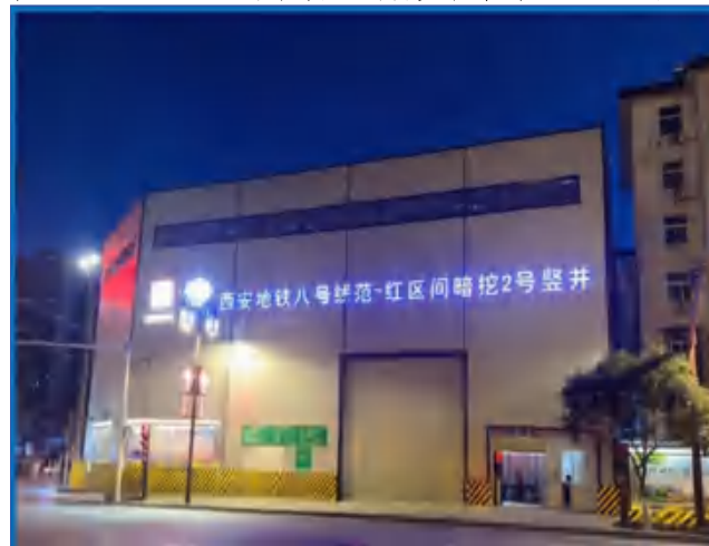
图9-64 全封闭厂棚实景图（夜间）
