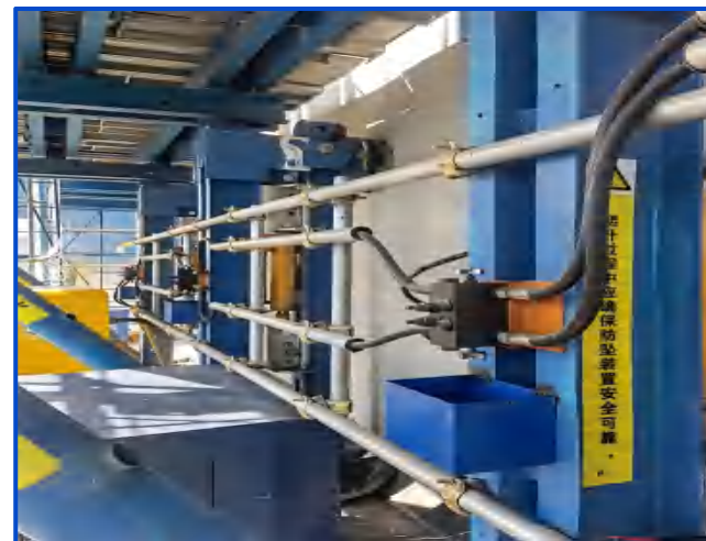
图3-37 爬模液压装置示意图
