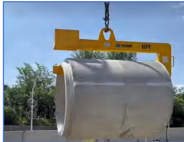
图9-21 管节吊装
