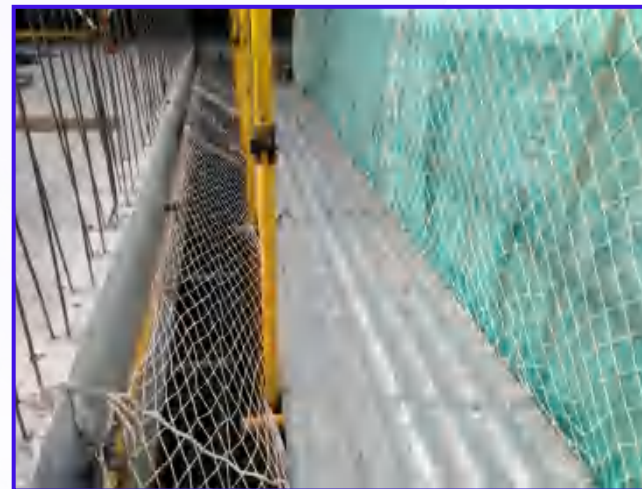
图2-15 作业层边缘水平防护（2）
