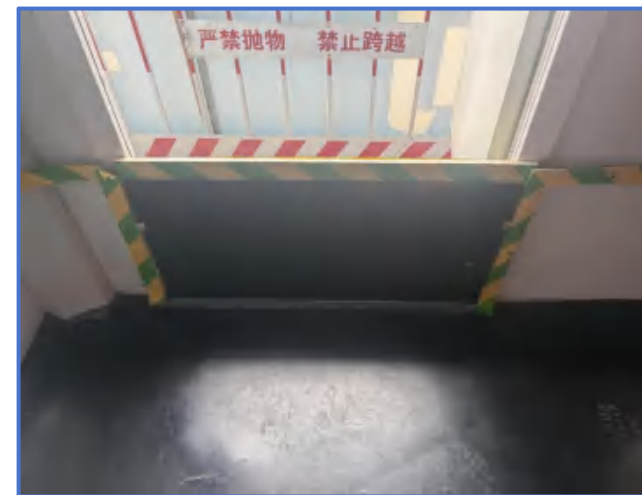
图4-5 设置挡鼠板
