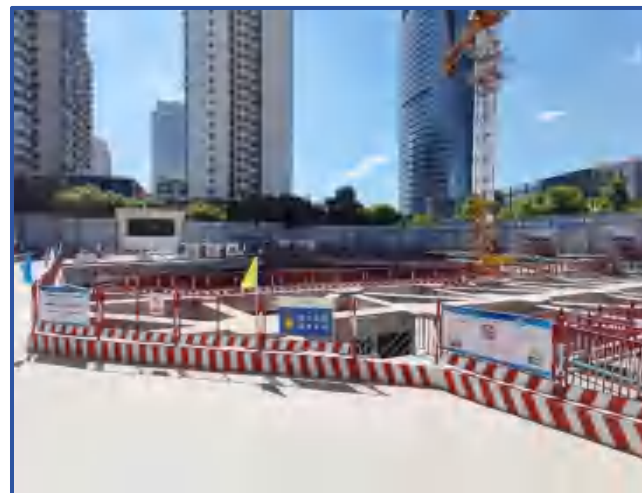
图1-20 工具式基坑临边防护（2）
