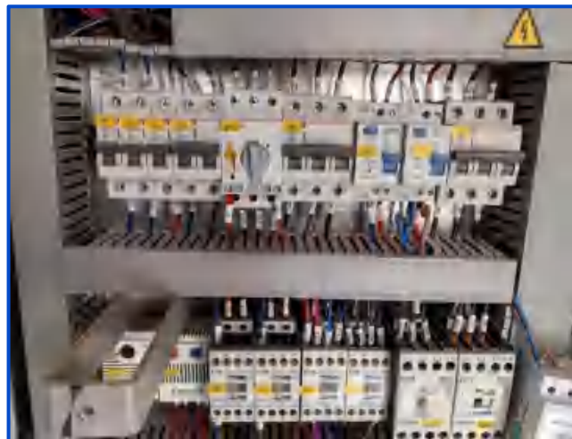
图5-7 欠压与过压装置
