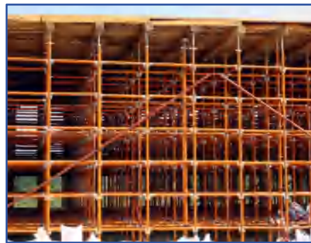
图3-29 承插型轮扣式支撑顶托设置
