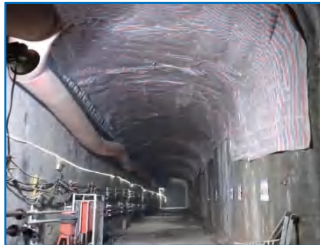
图9-82 隧道LED照明灯
