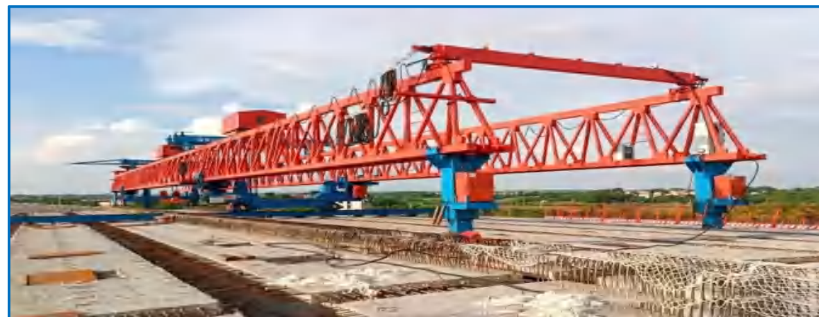
图9-52 架桥机实物图
