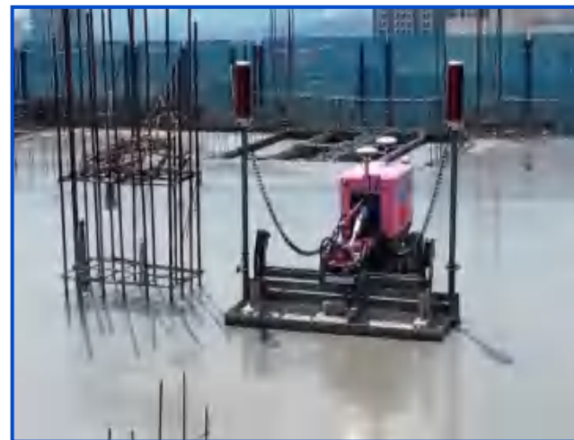
图10-62 地面整平机器人
