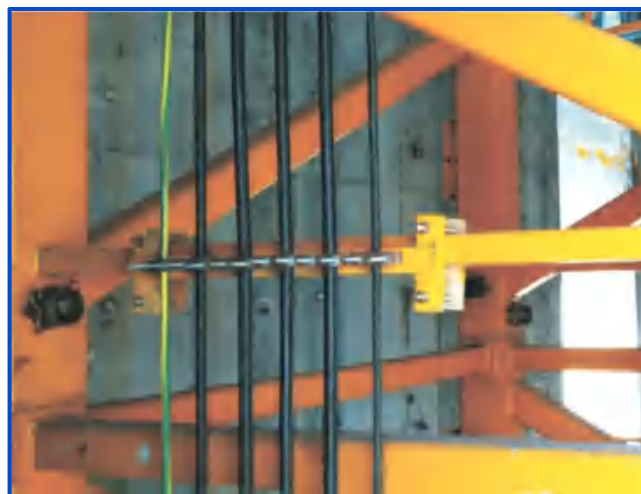
图5-9 塔吊主电缆绝缘、卸载
