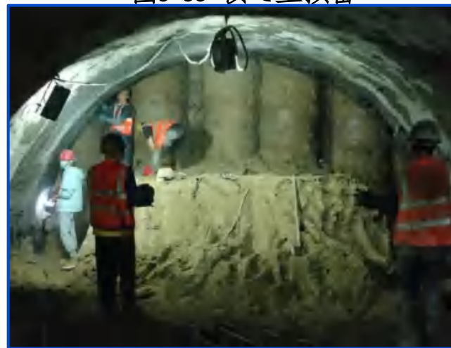
图9-100 隧道出洞围护桩破除施工
