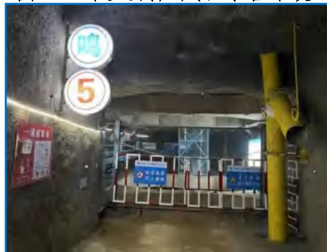
图9-86 横通道主风、水管布设
