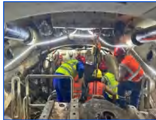
图9-128 盾构机开仓作业
