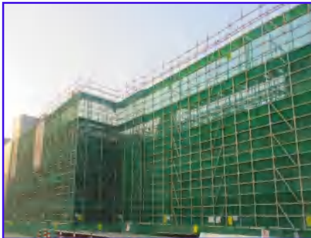
图2-10 端部、转角处搭设（1）
