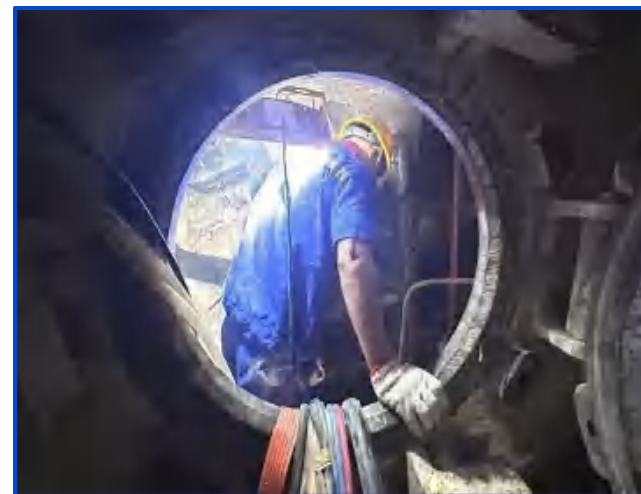
图9-129 作业人员进仓作业
