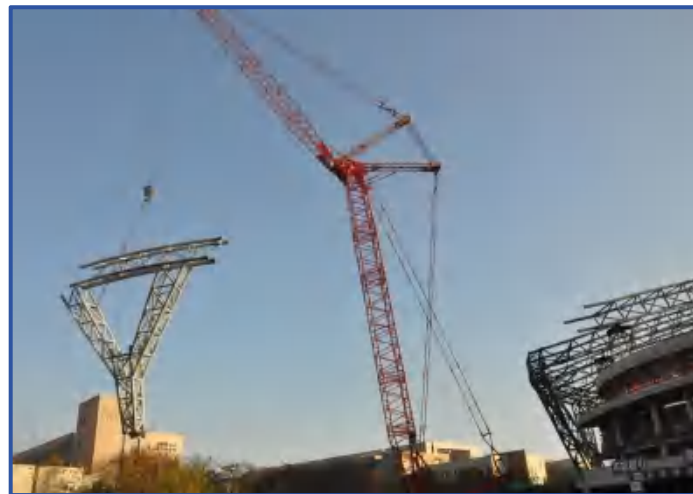
图7-6 钢结构整体吊装（1）
