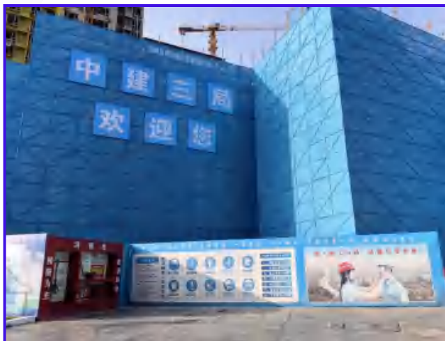
图2-13 钢板网片外立面防护（1）
