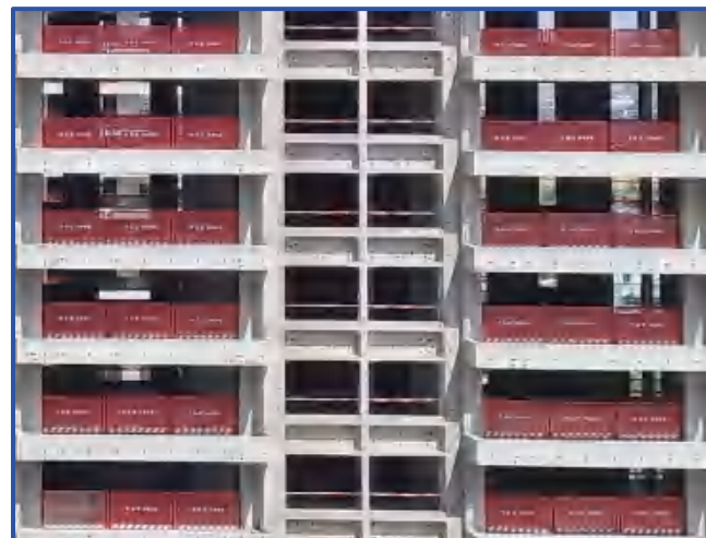
图6-23 定型化临边防护（2）
