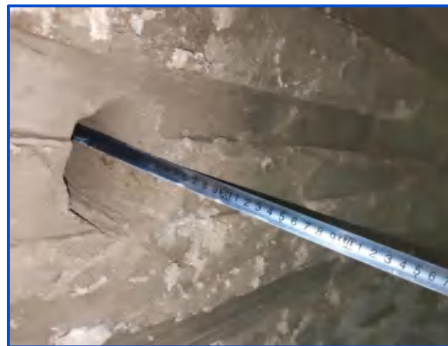
图9-95 超前地质探孔打设
