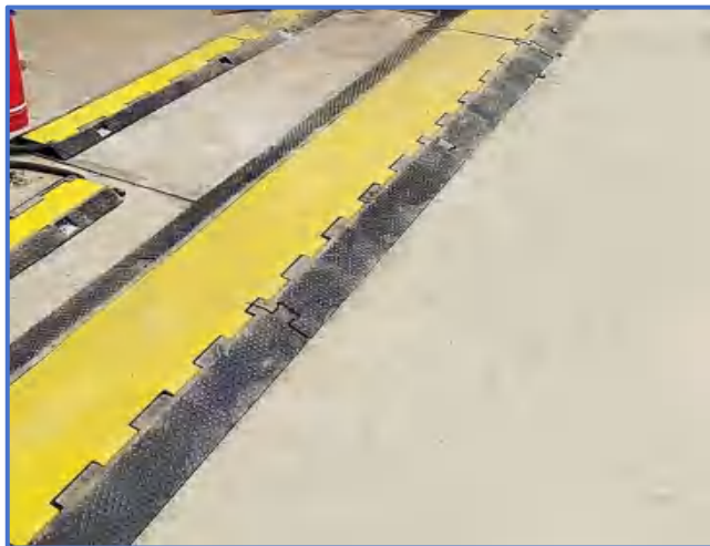
图4-10 电缆采用橡胶线槽线进行过地保护
