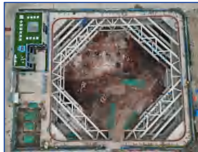
图1-13 基坑钢筋混凝土内撑支护（2）
