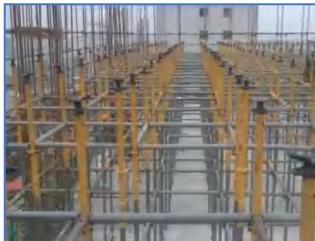
图3-26 承插型轮扣式支撑杆件设置
