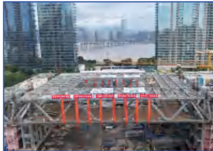
图7-8 网架整体提升施工
