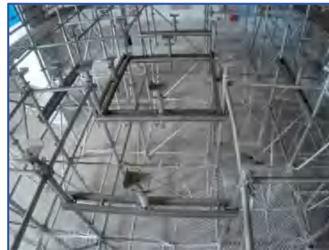
图3-9 承插型盘扣顶托设置 (2)
