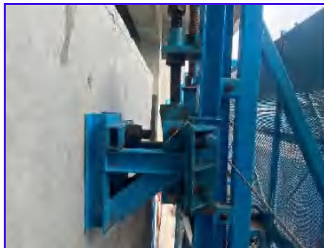
图2-36 附墙支座锚固螺栓（1）
