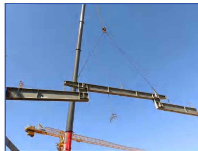
图7-5 钢梁吊装施工
