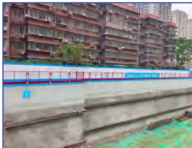
图1-10 基坑桩锚支护 (2)
