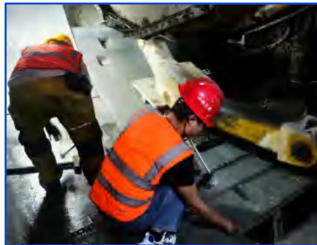
图9-133 管片拼装
