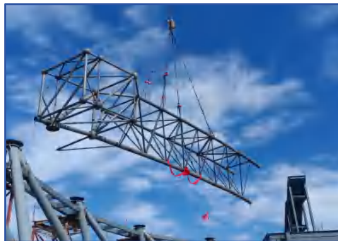
图7-6 钢结构整体吊装（2）
