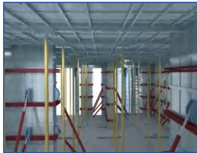
图3-33 同步设置支撑立杆
