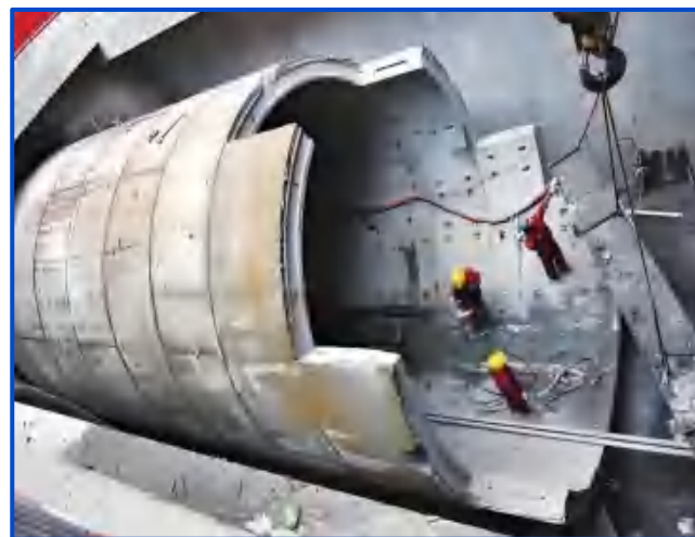
图9-121 负环管片拆除
