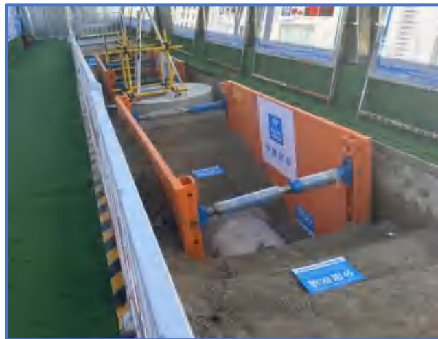
图9-19 沟槽钢板桩支护
