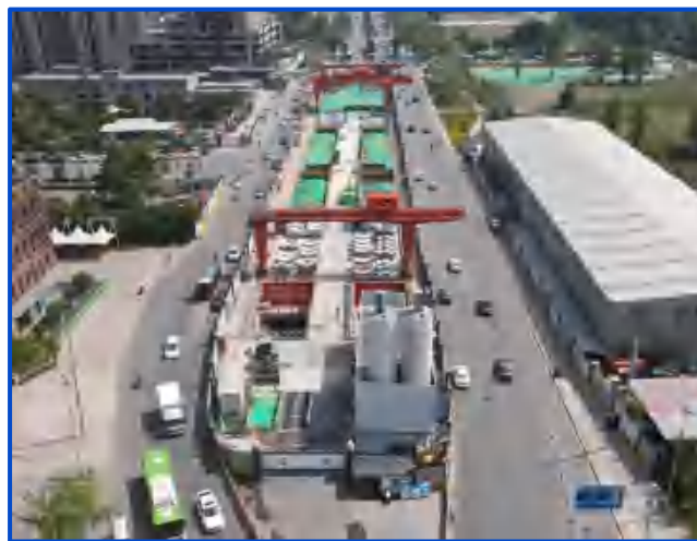
图9-106 盾构临建场地
