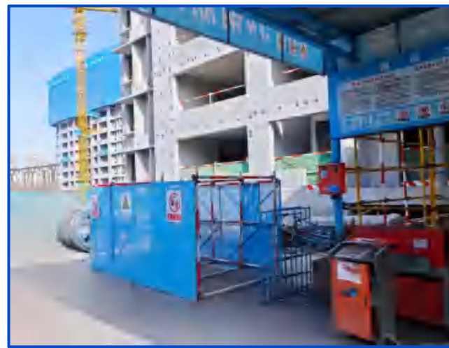
图5-125 调直机防护措施
