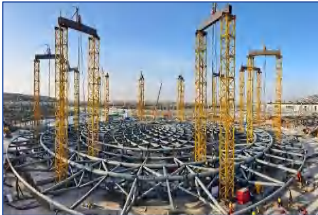
图7-7 网架整体提升准备阶段
