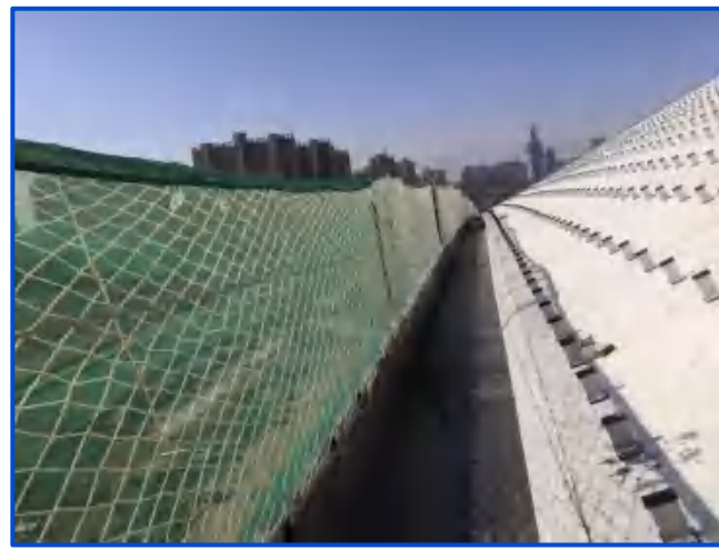
图6-25 斜屋面临边防护（2）
