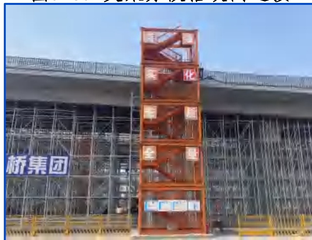
图9-40 支架上下梯道
