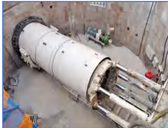
图9-31 千斤顶、油泵设置
