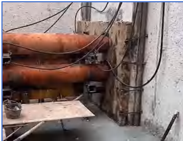
图9-27 顶管后背墙设置
