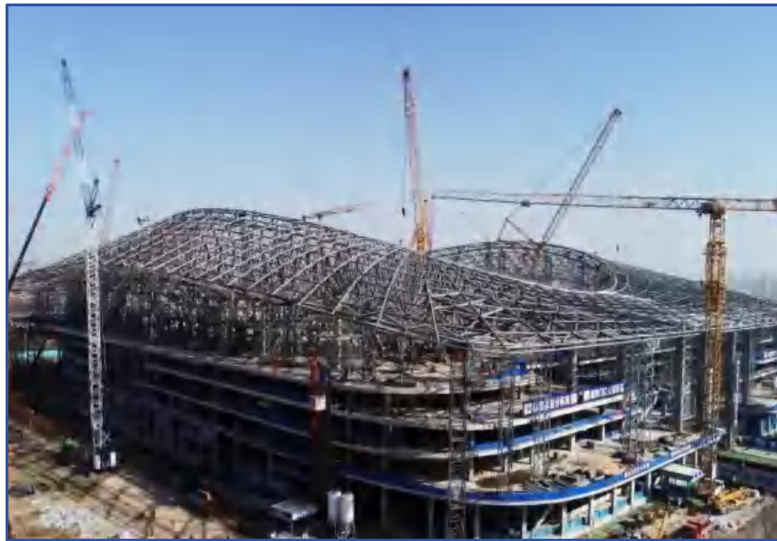
图7-10 索膜结构施工
