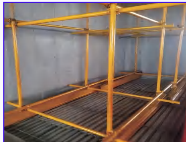
图2-17 电梯井操作架搭设
