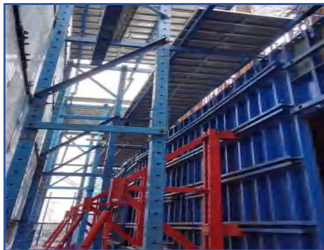
图3-38 爬模支撑示意图
