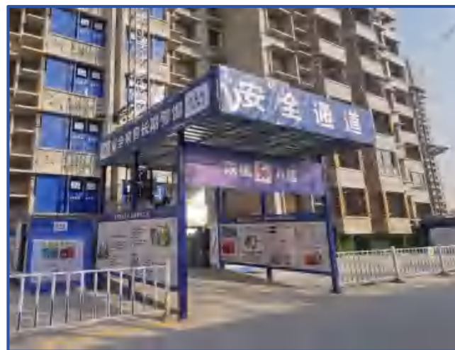
图6-27 施工升降机防护棚（4）
