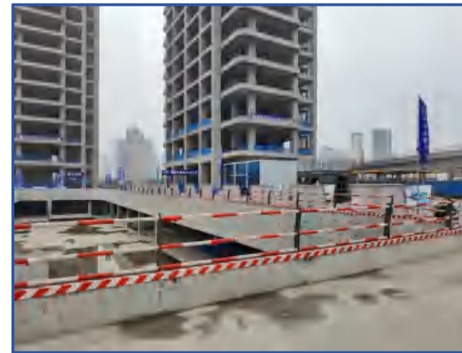
图6-19 反坎处临边防护
