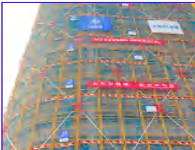
图2-7 剪刀撑设置（1）
