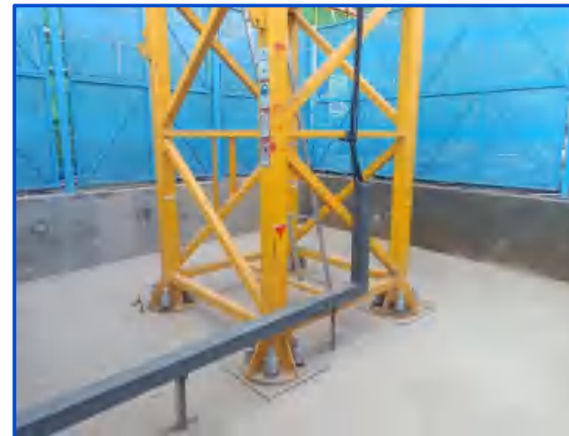
图5-8 设备接地（电气、防雷）
