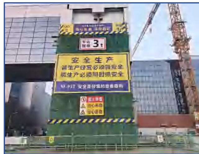
图6-34 落地式操作平台（2）
