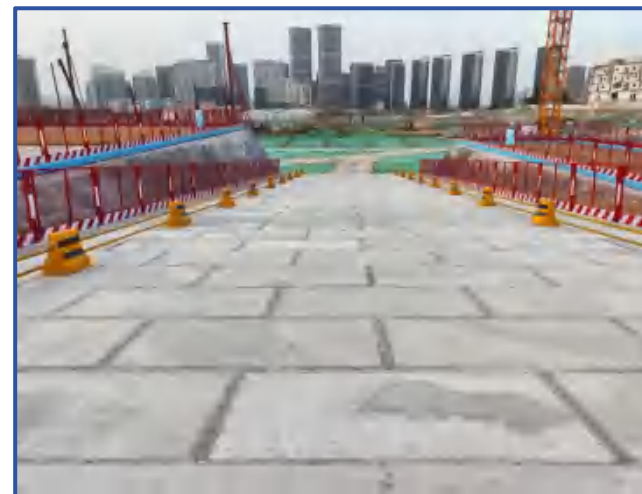
图1-25 基坑车行通道
