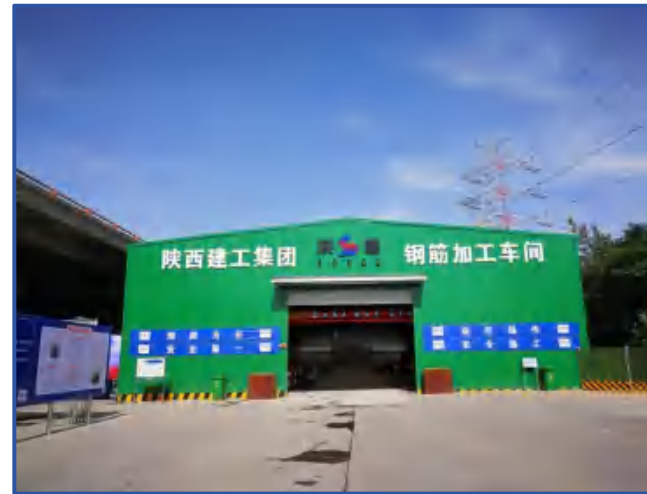
图6-29 封闭式钢筋加工车间
