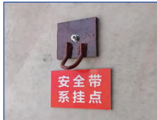
图6-6 安全带系挂点（2）
