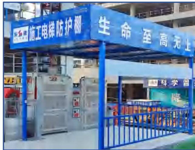
图6-27 施工升降机防护棚（2）
