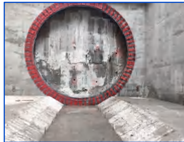
图9-123 盾构洞门密封
