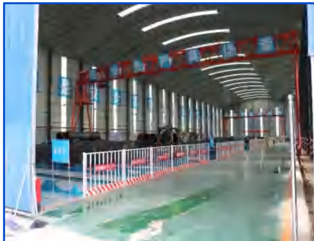
图5-83 场地封闭警示
