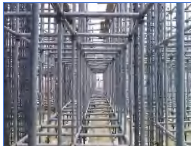
图3-27 承插型轮扣式支撑杆件设置
