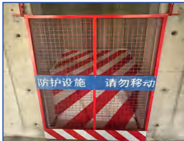
图6-16 电梯井水平防护
