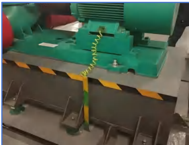
图4-25 用电设备保护接地导体
