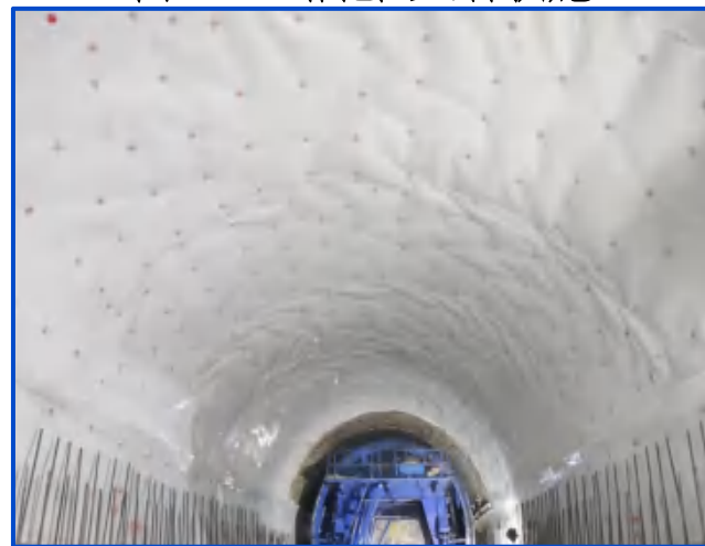
图9-102 暗挖隧道拱墙防水施工
