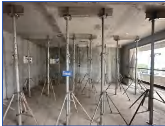
图7-37 预制构件可调式独立钢支撑体系
