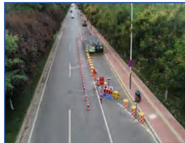
图9-16 非机动车道占道作业
