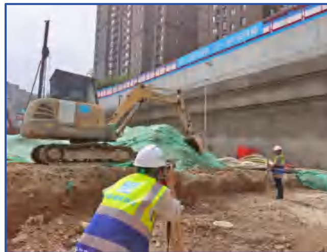
图1-5 基坑开挖标高及尺寸控制
