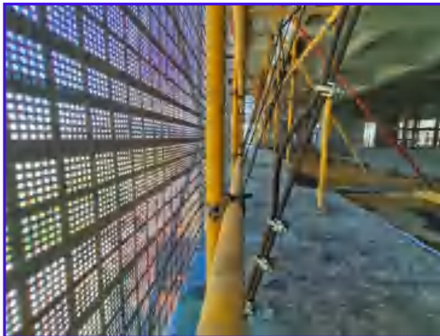
图2-26 斜拉钢丝绳设置
