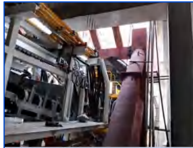
图9-119 反力架安装
