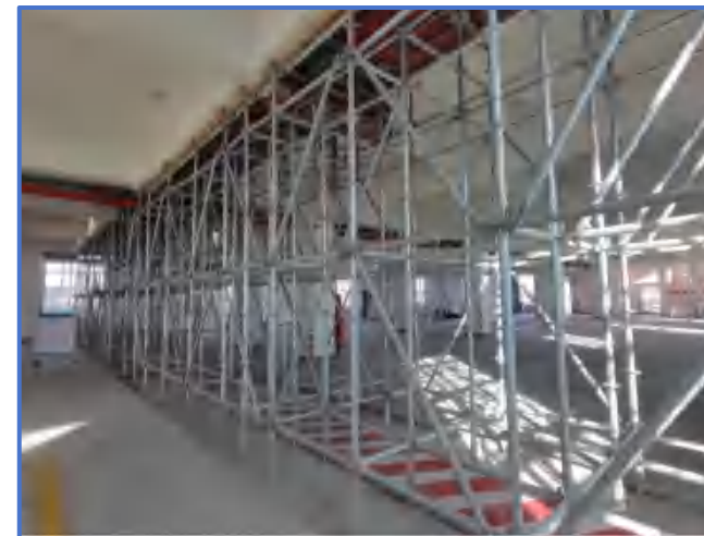
图3-43 后浇带支撑图
