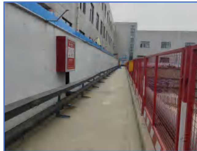
图4-11 定型化电缆桥架
