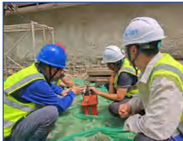
图1-12 锚杆抗拔试验
