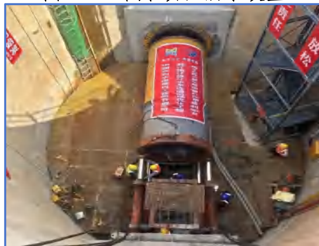
图9-32 顶管机安装
