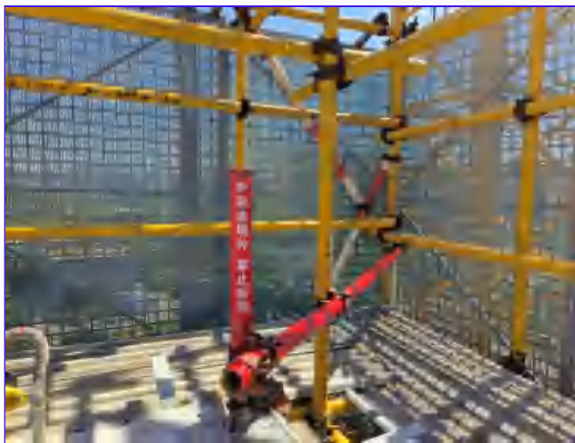
图2-5 转角处连墙件设置
