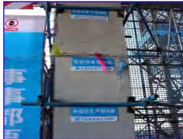
图2-4 脚手架连墙件设置 (2)
