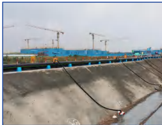
图1-28 基坑降水井环圈式布置
