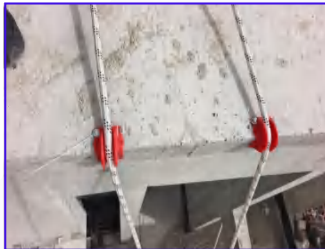
图2-49 安全绳阳角保护
