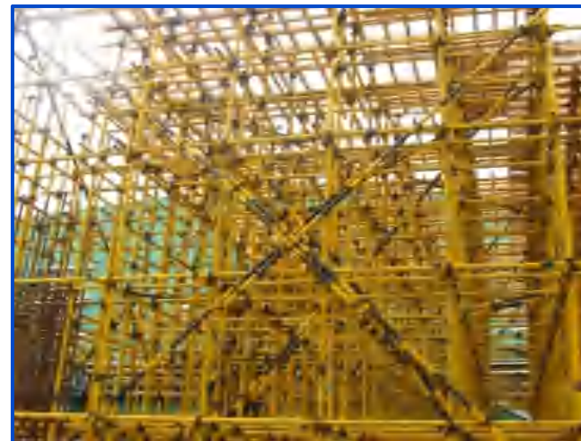
图3-19 扣件式钢管竖向剪刀撑
