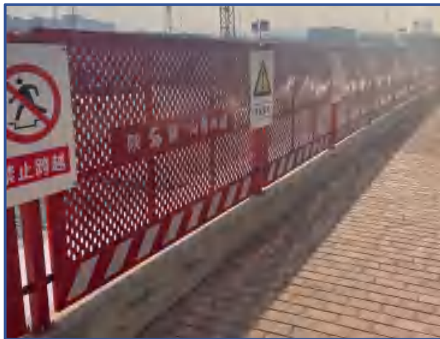
图6-24 基坑临边防护（1）
