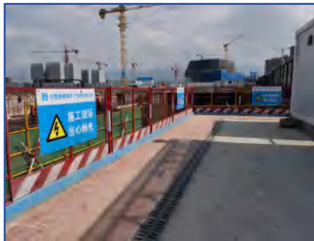
图1-26 基坑挡水坎及排水沟
