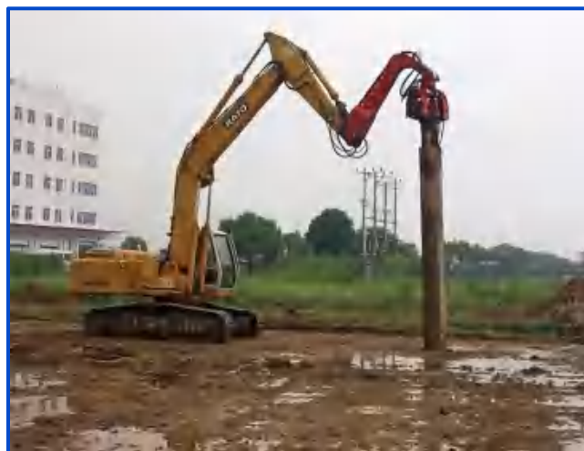
图5-119 振动沉管桩机
