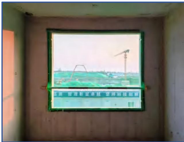
图6-18 窗台处洞口临边防护
