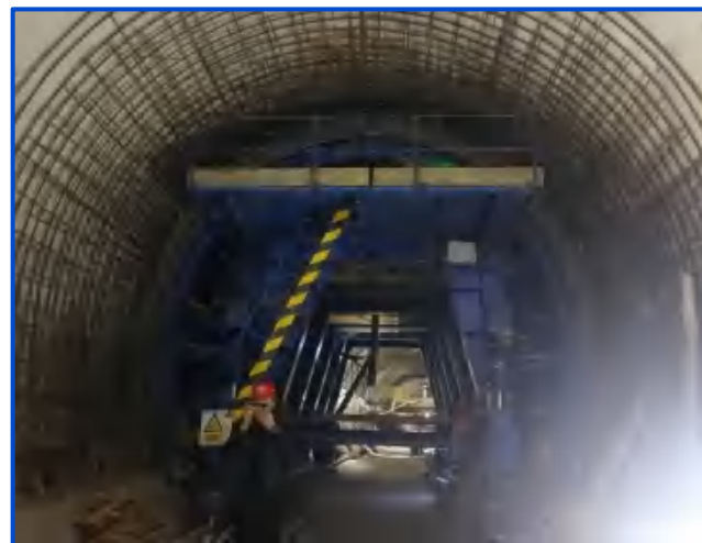
图9-103 暗挖隧道拱墙混凝土浇筑施工
