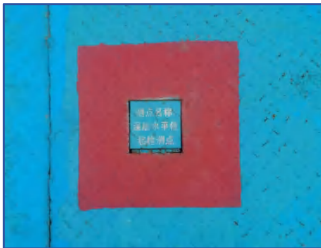
图1-34 基坑深层水平位移监测点
