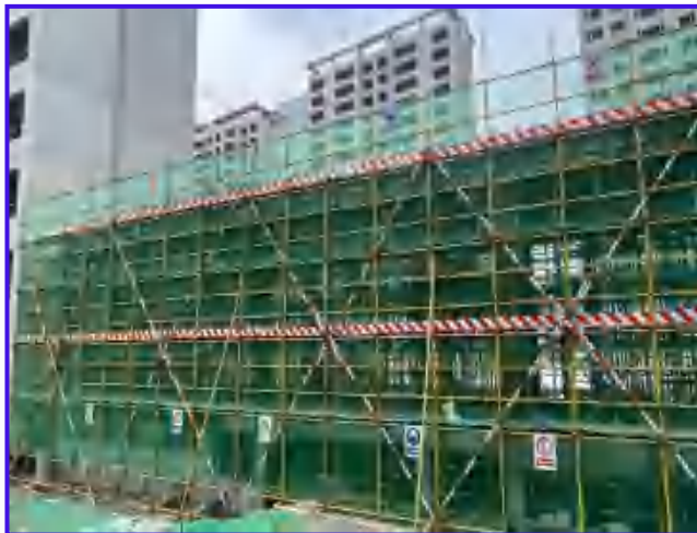
图2-12 安全网外立面防护（1）
