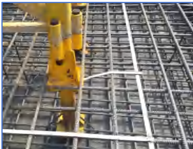
图4-30 塔吊接地示意图
