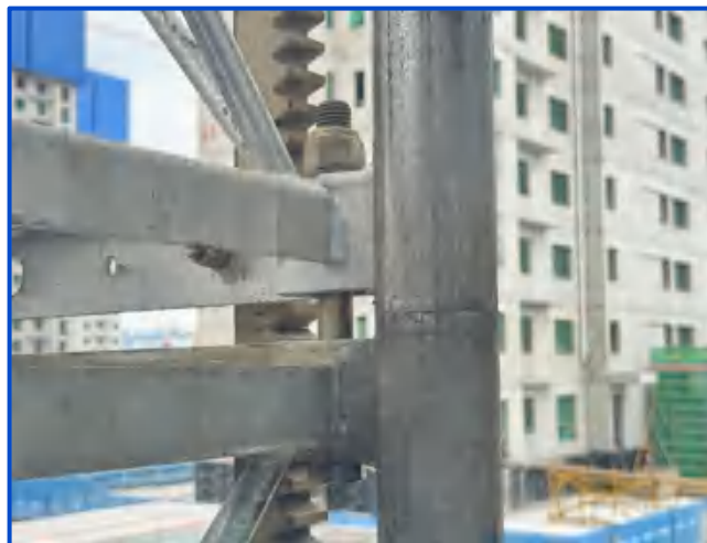
图5-50 标准节螺栓连接
