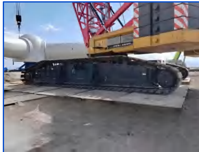
图5-102 行走路线铺设路基板
