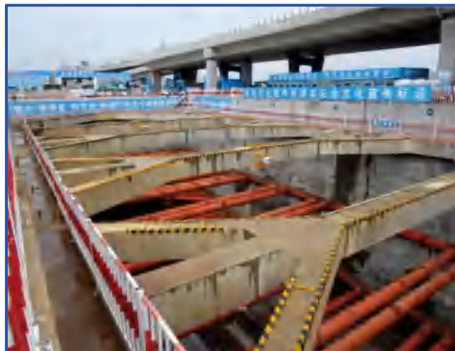
图1-13 基坑钢筋混凝土内撑支护（3）
