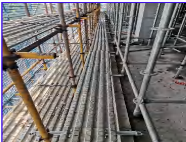
图2-15 作业层边缘水平防护（1）
