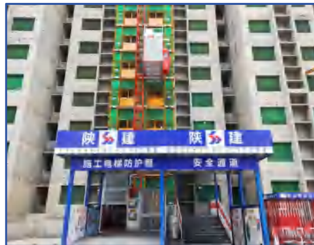
图6-27 施工升降机防护棚（3）
