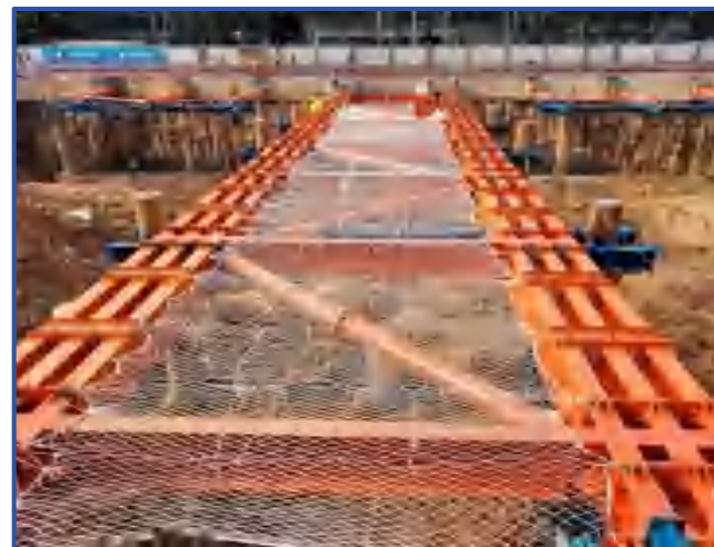
图1-16 钢支撑支护（1）
