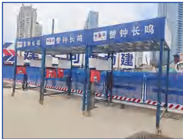
图6-31 小型机械防护棚 (3)
