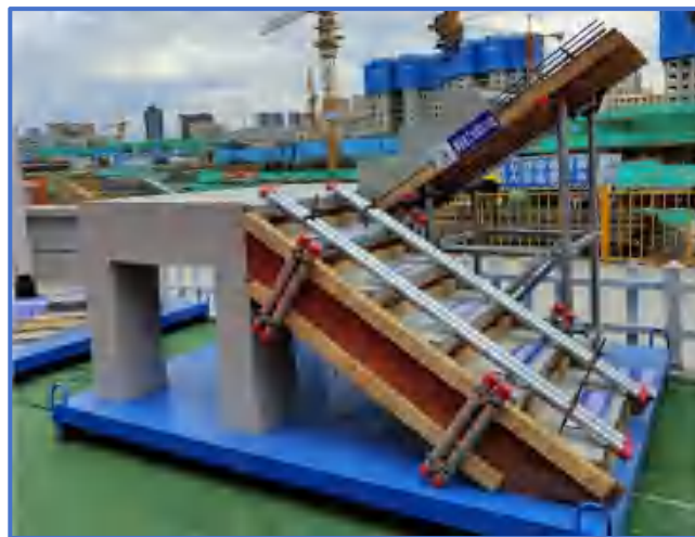
图3-48 楼梯标准层支撑图
