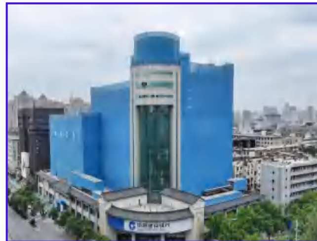
图2-13 钢板网片外立面防护（2）
