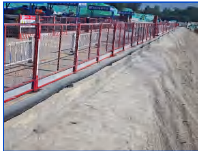
图6-24 基坑临边防护（2）
