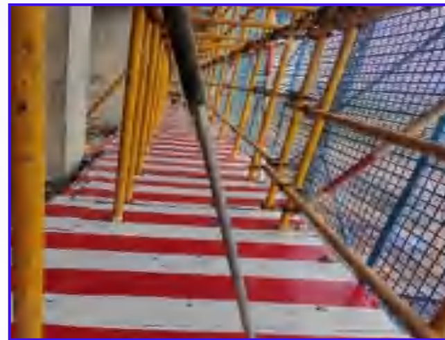
图2-25 短肢悬挑梁斜拉杆
