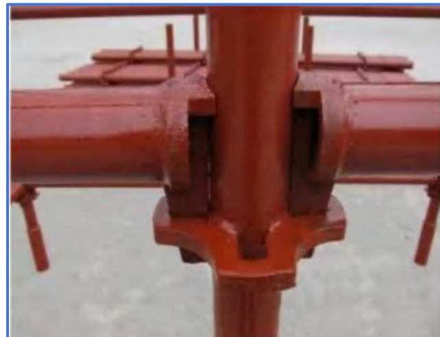
图3-25 轮扣式连接大样
