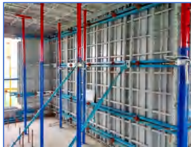
图3-32 铝模安装墙、柱、梁、板
