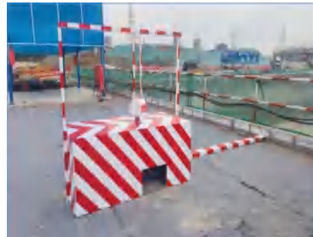
图5-123 圆盘锯防护罩
