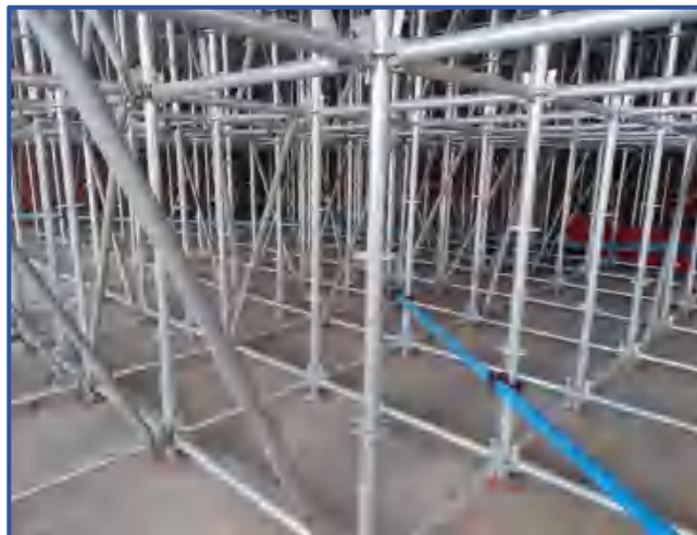
图3-5 扫地杆设置层水平剪刀撑
