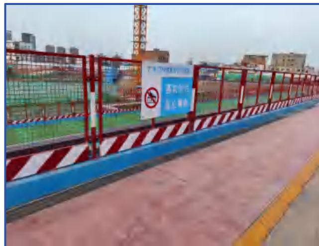
图1-20 工具式基坑临边防护（1）
