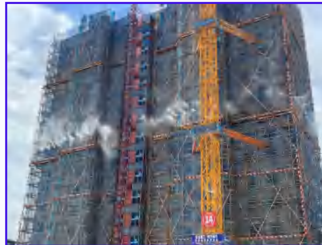
图2-12 安全网外立面防护（2）
