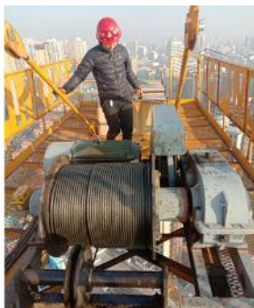
大型机械现场检查
