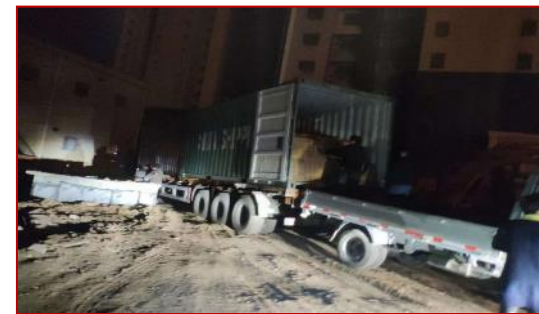
材料到场，连夜上楼
