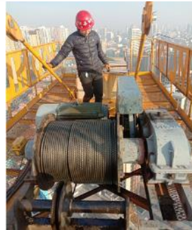
大型机械现场检查
