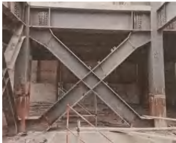
柱间支撑焊接连接
