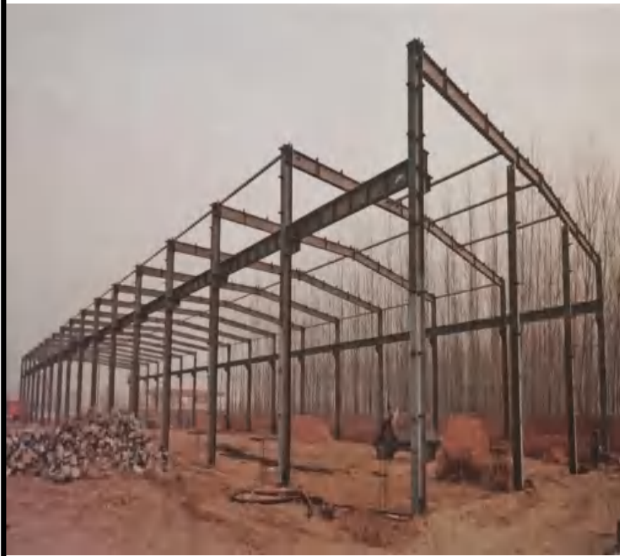
(3)H 型钢柱现场及图纸表示：左右两边皆为垂直 90°。
