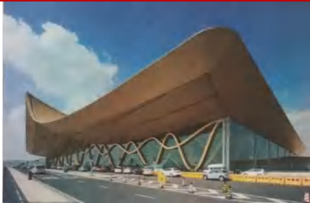
大跨度钢结构
