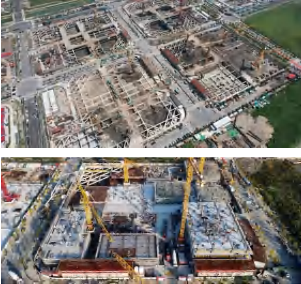
图 4-4 工地现场照片
