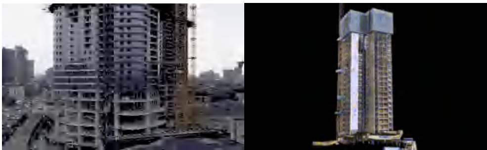
图 4-4 建筑立面无人机自主巡检及表面病害检测
