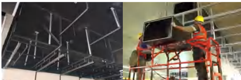
图 4-3 现场机电支吊架与装修龙骨同步施工以及风管预制化下料装配化施工
