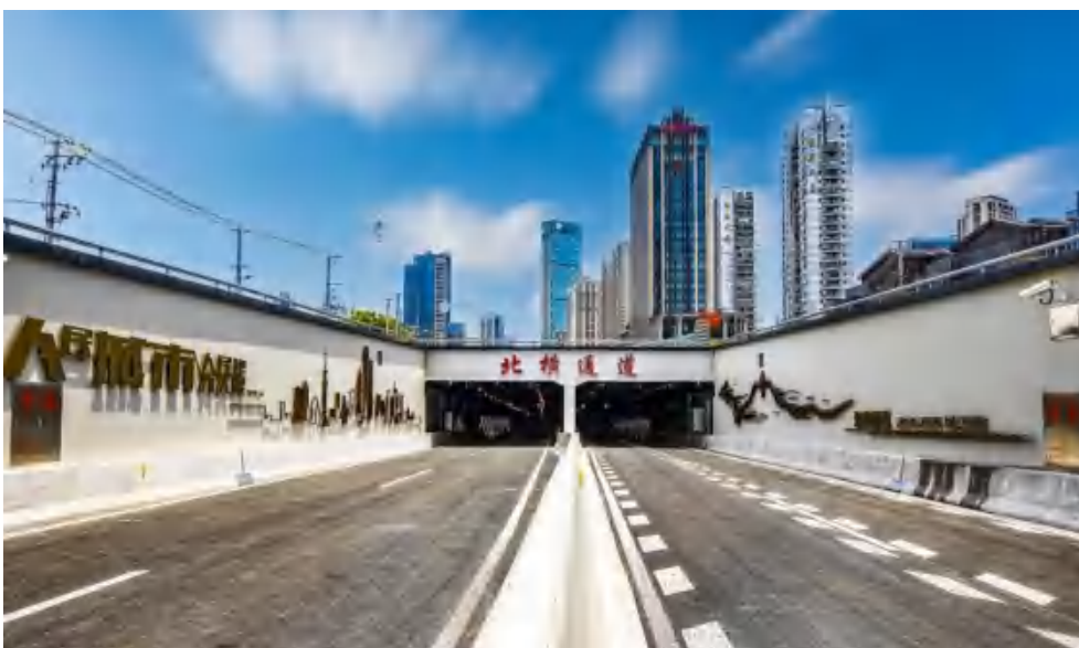
图 1-1 北横通道东段工程实景图
