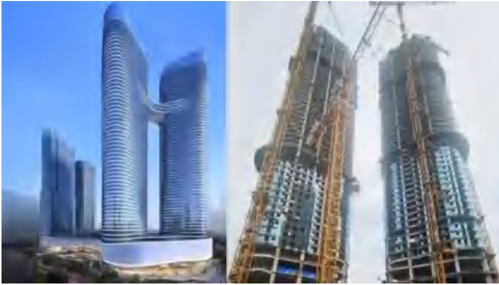
图 4-2 建筑高度 243.9m 的双子塔
