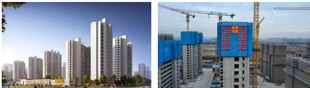
图 3-6 项目效果图及施工过程
