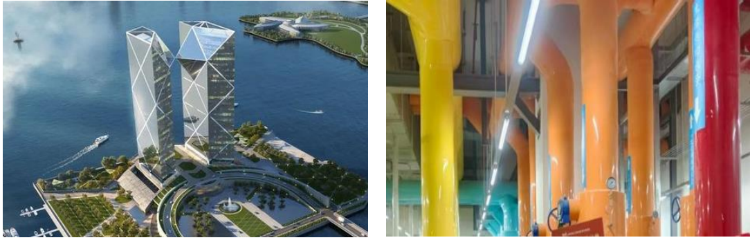
图 3-8 项目效果图及施工过程
