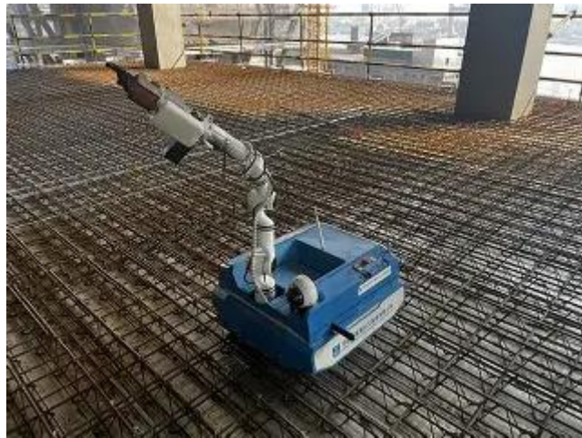
图 5-10 钢筋绑扎机器人
