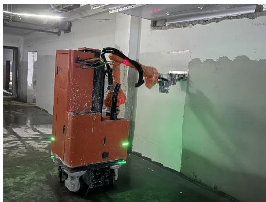
图 5-19 墙面喷涂机器人
