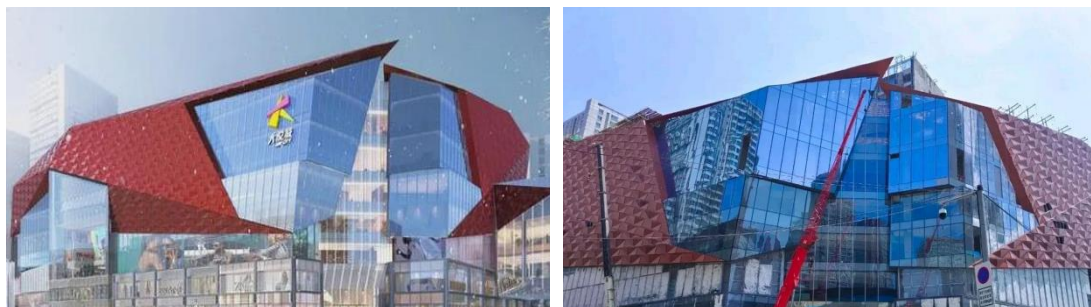
图 3-10 项目效果图及施工过程
