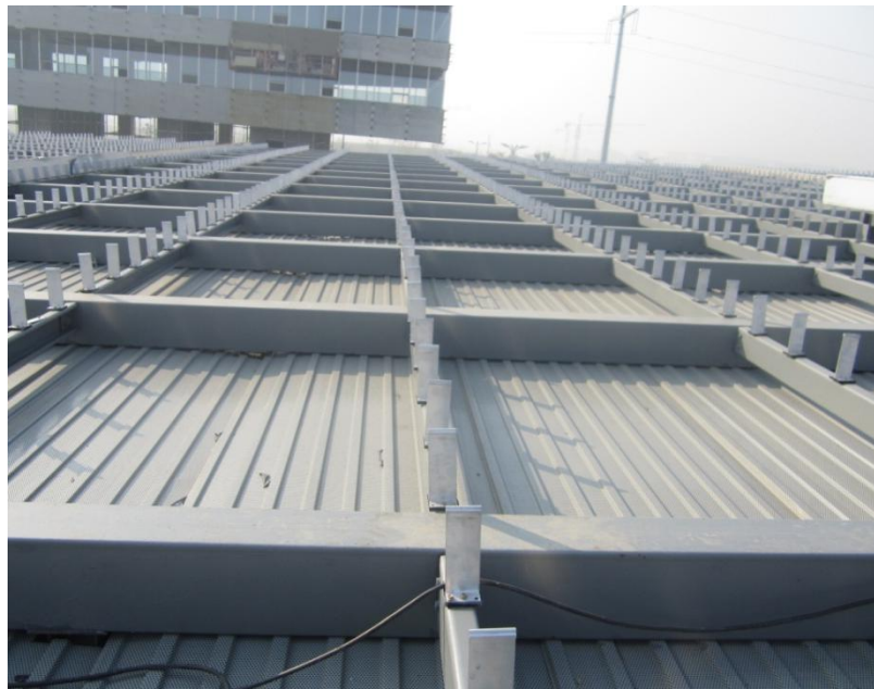
屋面T型固定支座布置示意图
