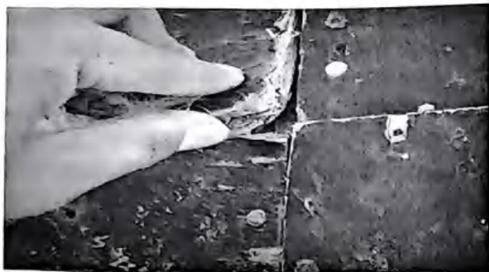
图 1-15 相关负责人现场检查 (续)
