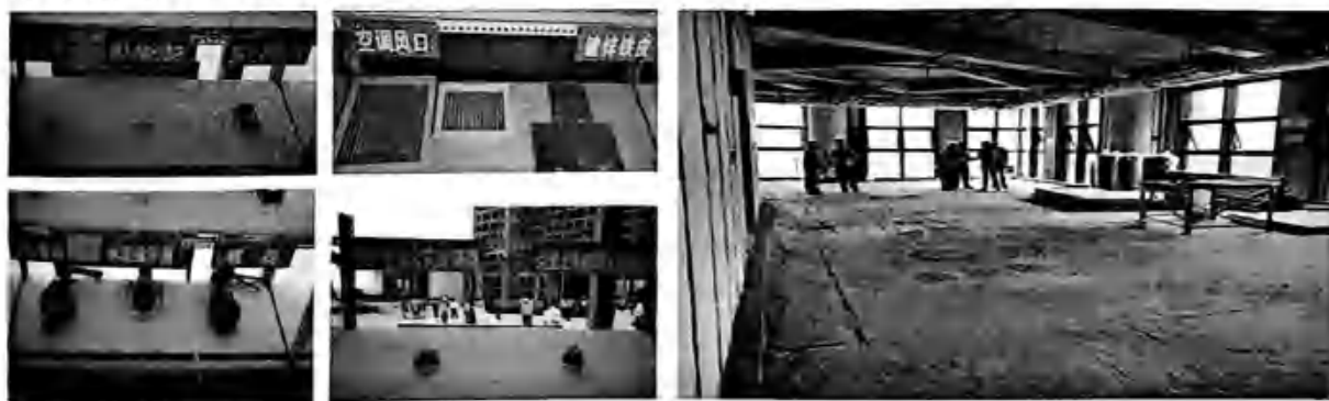
图 4-6 样板领路及现场交底
