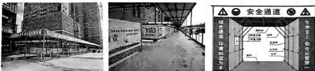
图 4-23 安全通道口防护图
