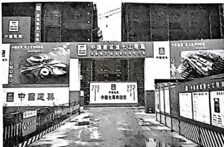
图 3-8 施工现场大门和七牌一图
