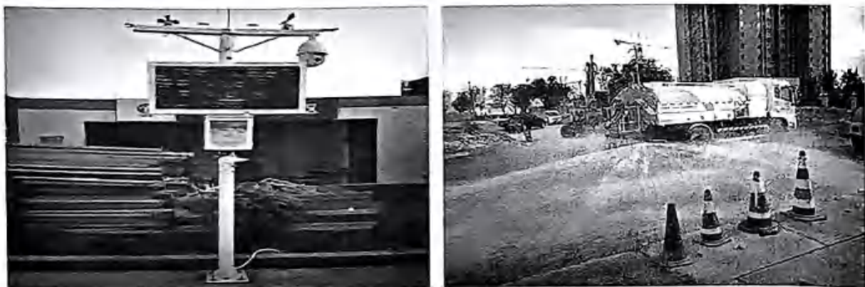
图 4-44 扬尘监控、洒水降尘图
