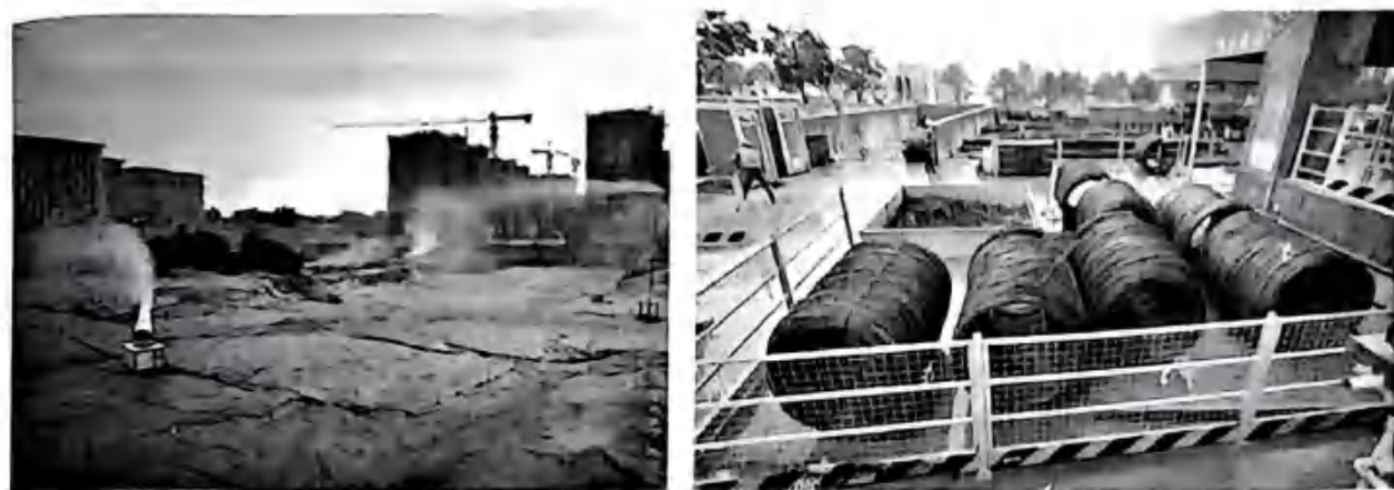
图 4-47 裸土覆盖及材料场地硬化图
