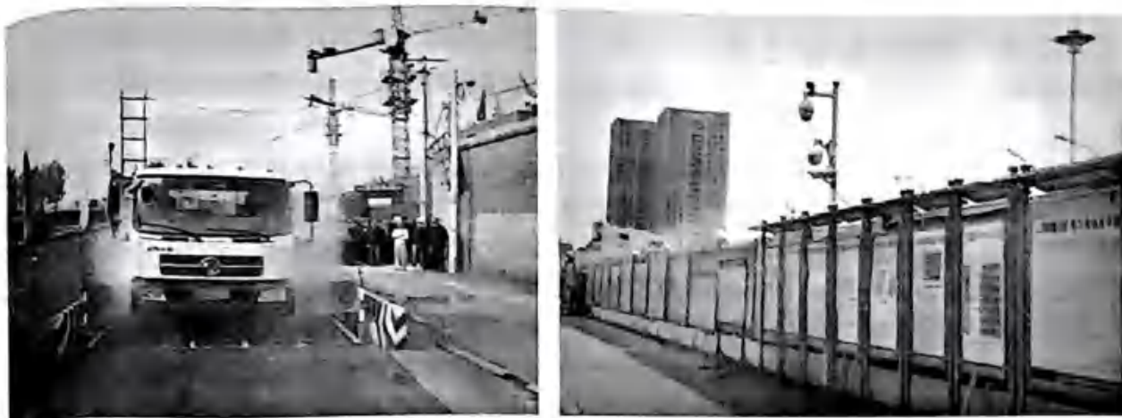
图 4-46 车辆冲洗、围挡喷淋洒水降尘图
