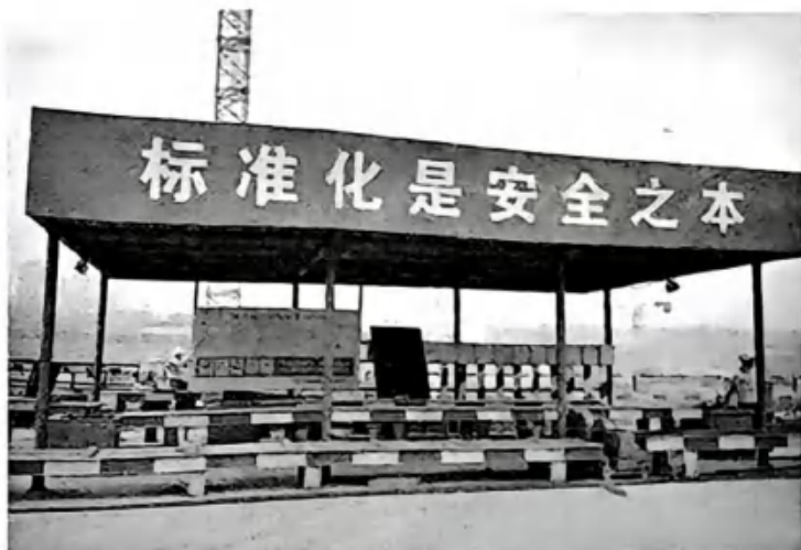
图 3-26 钢筋加工车间
