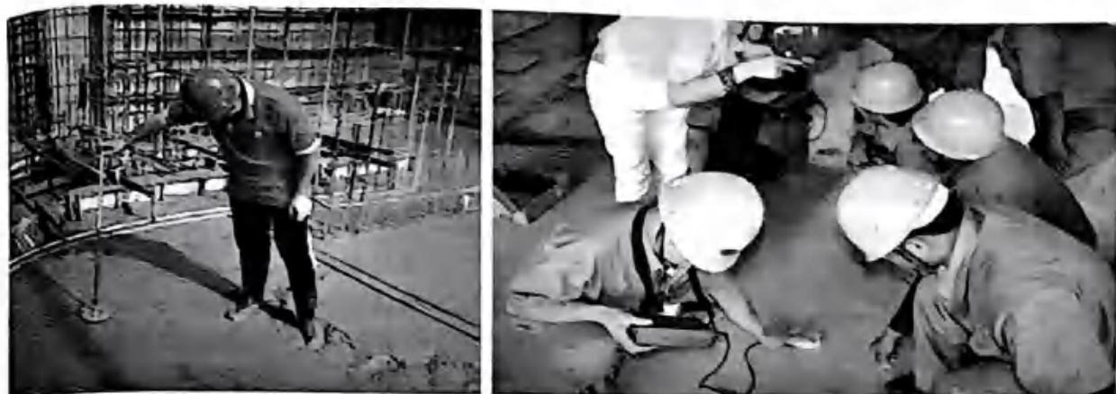
图 4-11 楼板厚度控制检查
