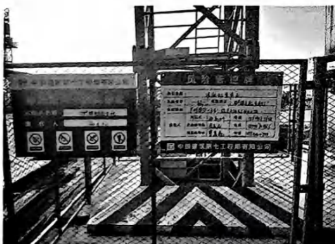
图 3-13 塔式起重机基础防护
