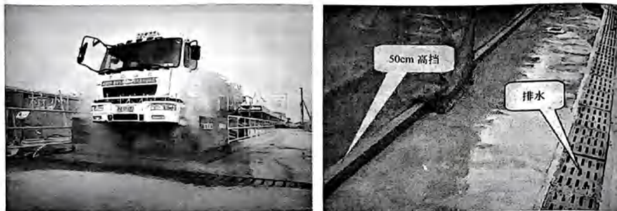
图 4-36 洗车及临时排水系统图
