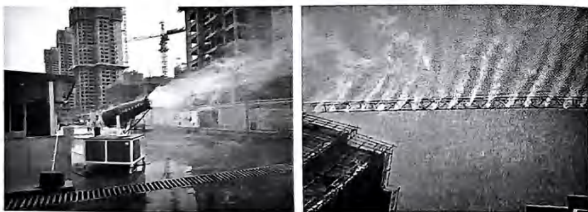
图 4-45 雾炮、塔式起重机洒水降尘图
