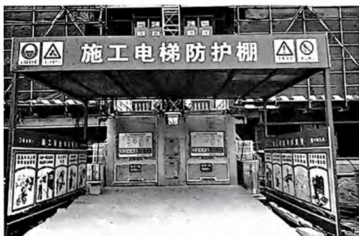
图 3-22 施工电梯防护棚
