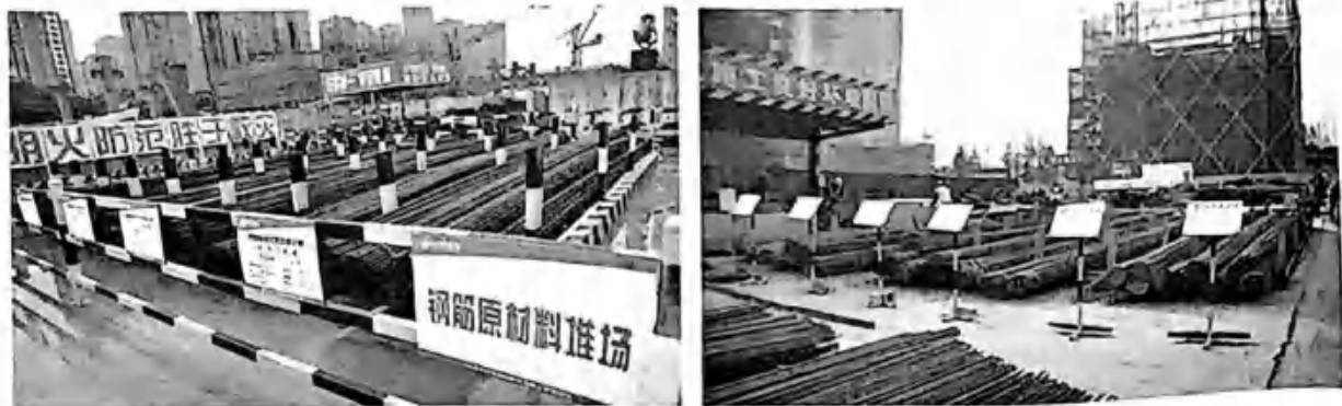
图 4-39 钢筋材料存放图
