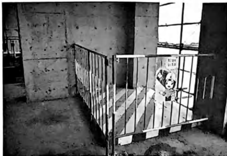
图 3-20 预留洞口标准化防护
