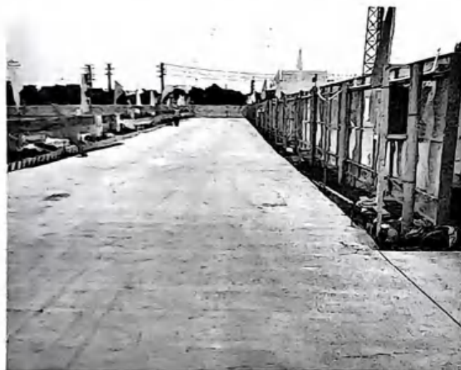
图 3-18 基坑临边标准化防护
