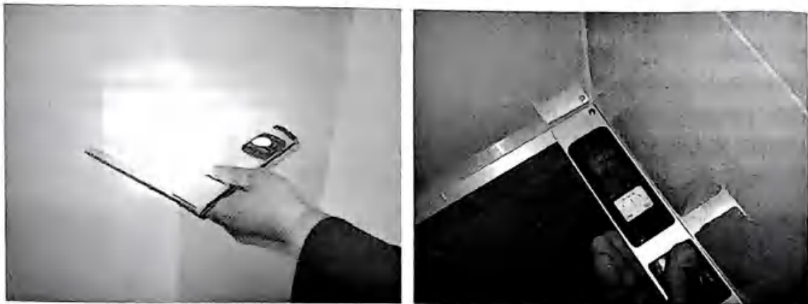
图 4-9 阴、阳角方正检查
