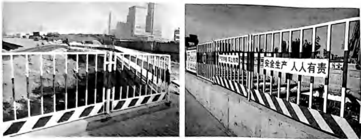
图 4-27 基坑临边防护图
