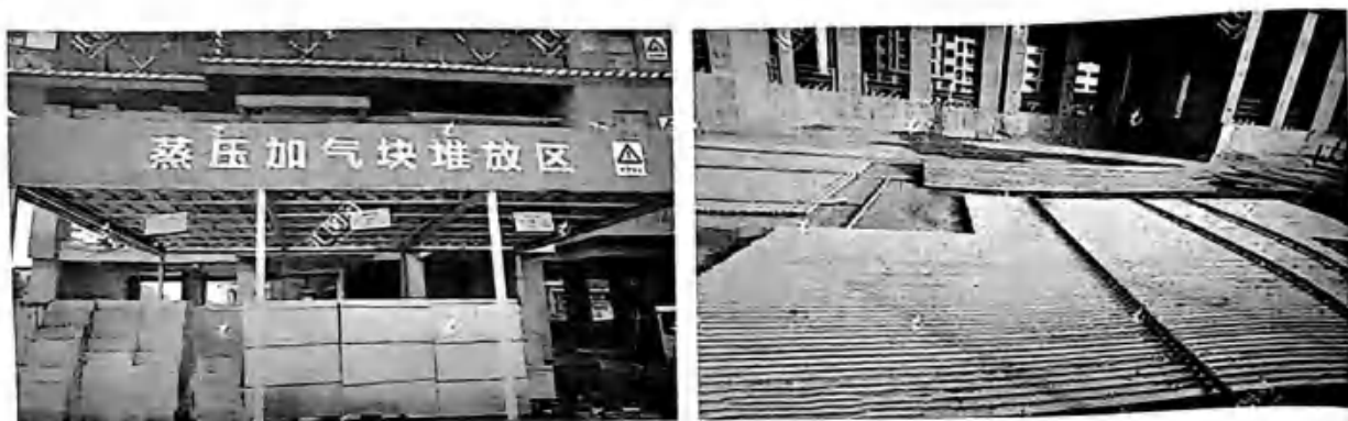
图 4-40 砌块和钢管材料存放图
