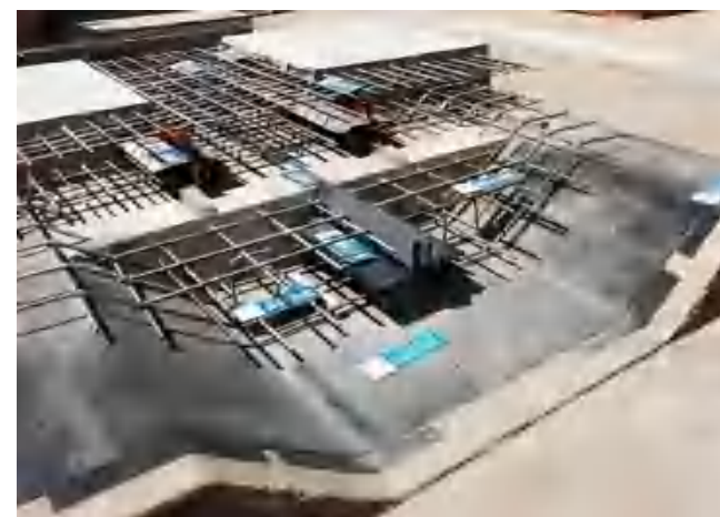
底板后浇带超前止水防水构造样板
