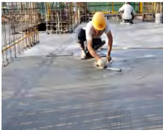
顶板混凝土第二次收面
