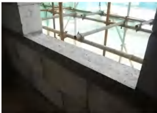
砌体墙窗洞下口设混凝土窗台压顶
