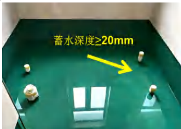
厕浴间防水层完成后进行蓄水试验
