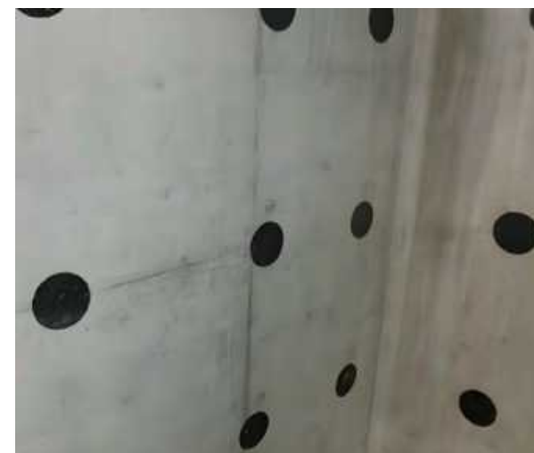
侧墙螺栓孔封堵后涂刷防水涂料
