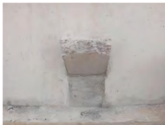
室内喇叭口部位多余混凝土凿除
