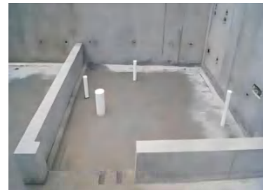
涉水房间混凝土坎台
