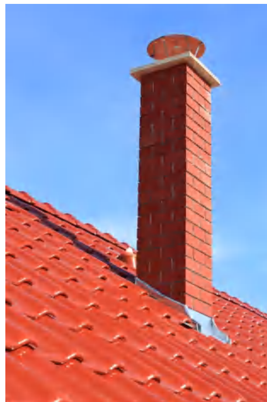
瓦屋面烟囱实物图
