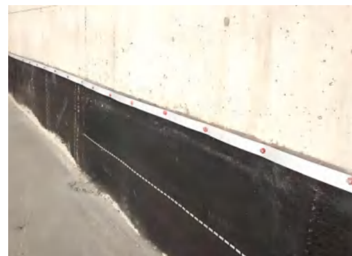
地下侧墙防水压条收头
