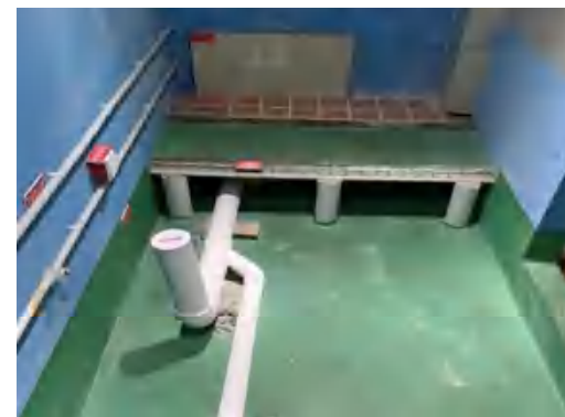
下沉式卫生间管道安装
