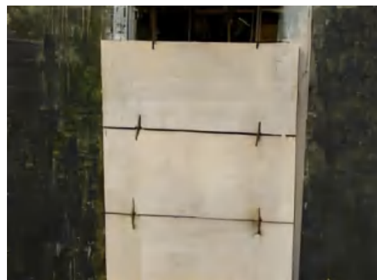
预制混凝土块安装
