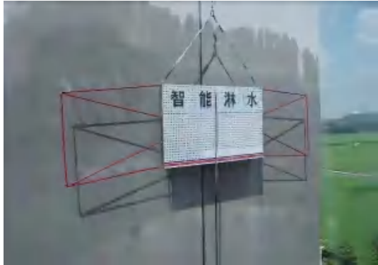
建筑外墙防水淋水试验
