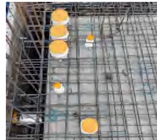
止水节临时封堵保护
