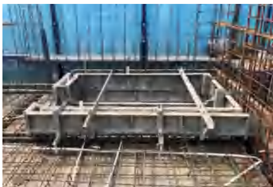
涉水房间混凝土坎台吊模实物图
