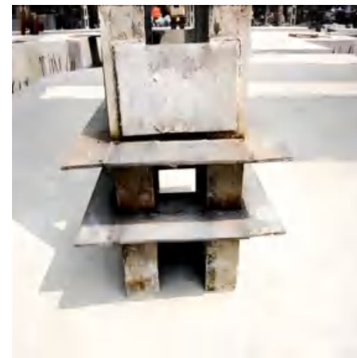
格构柱防水做法实物
