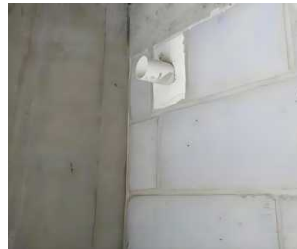
空调洞预制块埋置
