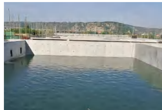
水池满池蓄水试验
