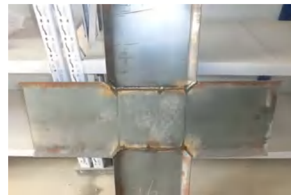
十形止水钢板焊接
