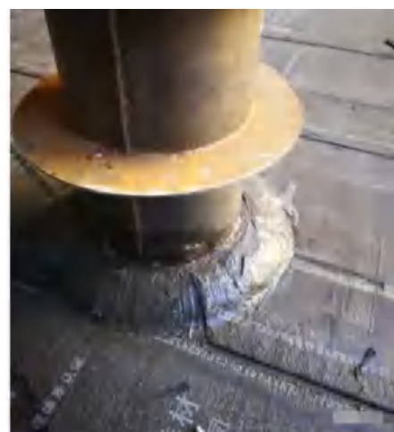
降水井穿越底板防水处理
