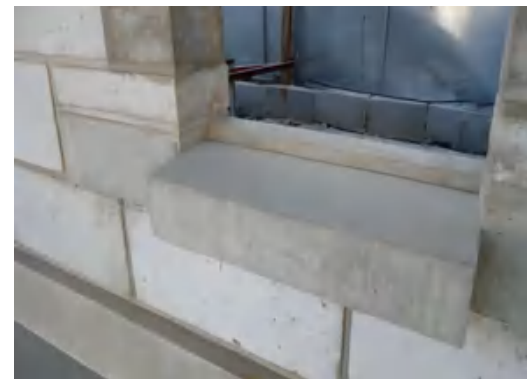
砌体墙窗洞下口设混凝土窗台压顶
