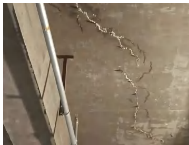
顶板裂缝注浆封闭
