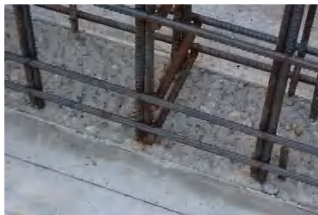
外墙层间接缝处混凝土凿毛处理
