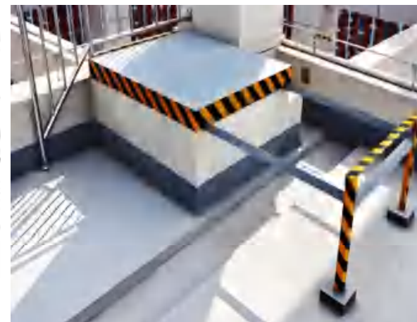
屋面垂直出入口实物图
