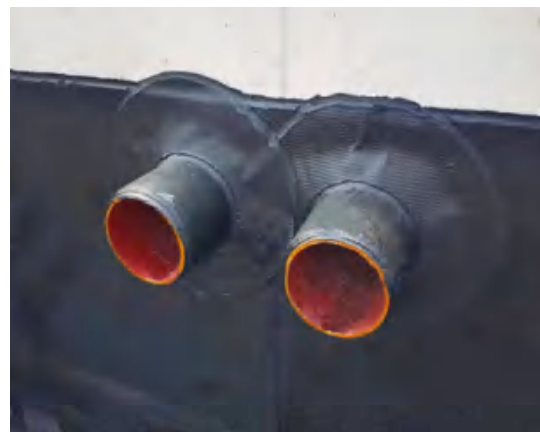
固定式穿墙管安装
