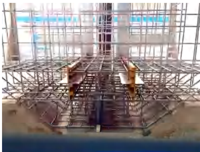
底板后浇带超前止水防水构造样板
