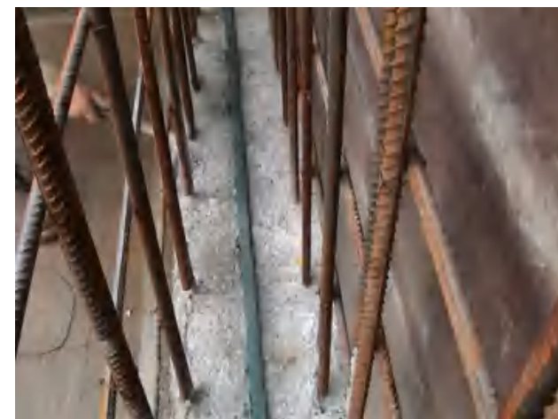
遇水膨胀止水条安装实物
