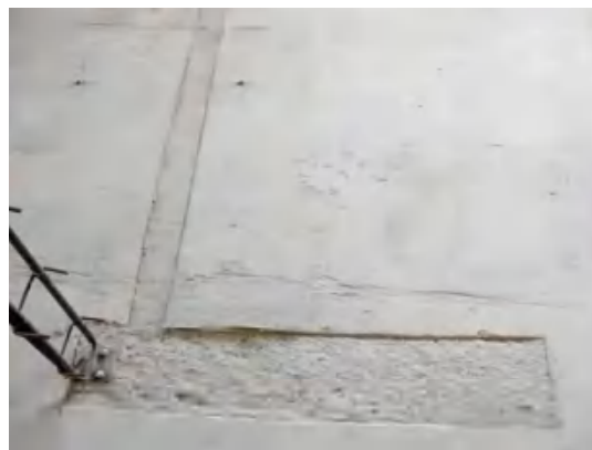
混凝土坎台凿毛
