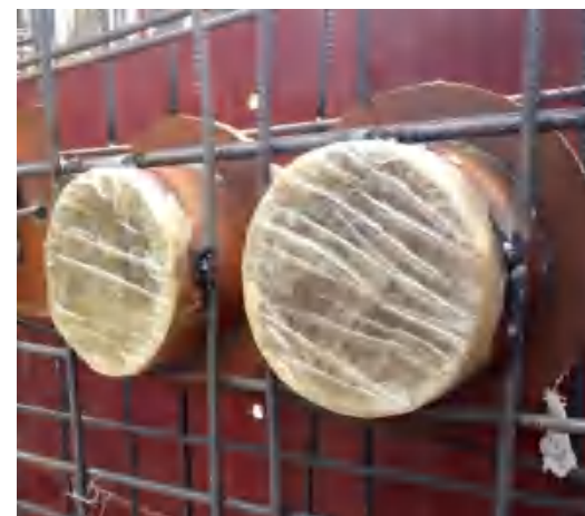
套管式穿墙管安装
