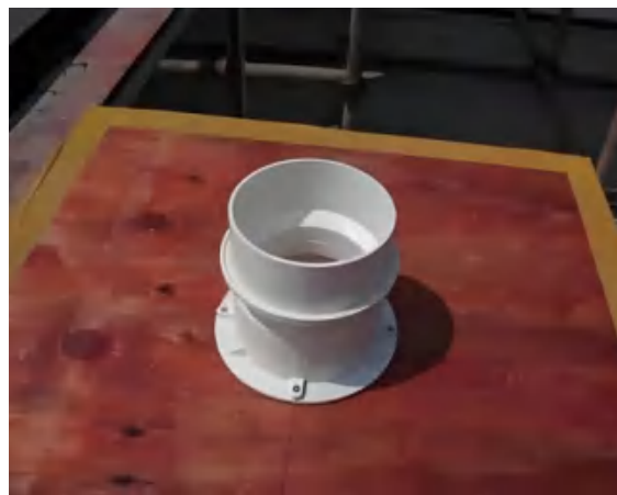
止水节安装固定
