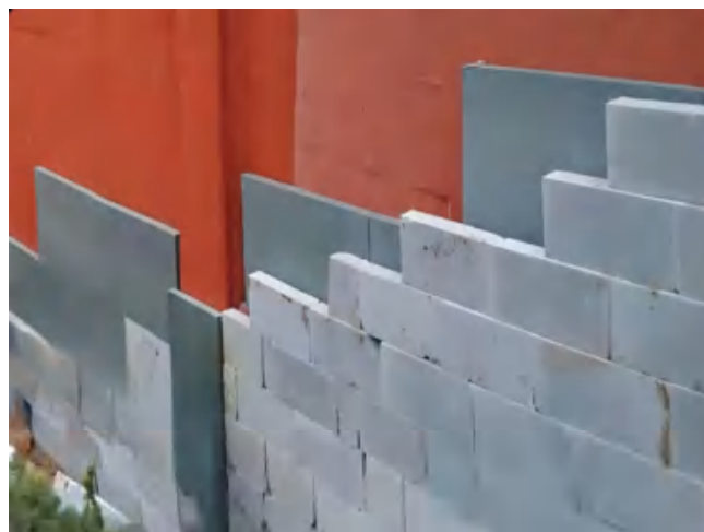
软保护层加砖保护墙
