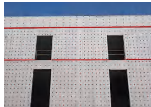
外墙层间接缝处涂刷防水涂料实物图
