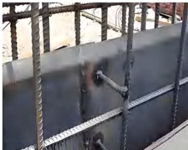
外墙止水钢板短钢筋焊接固定
