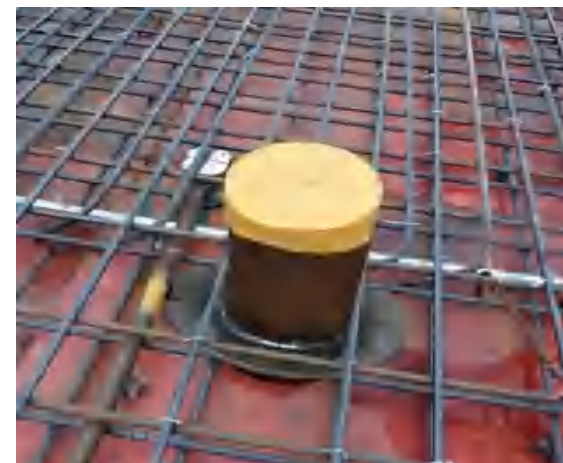
防水套管安装
