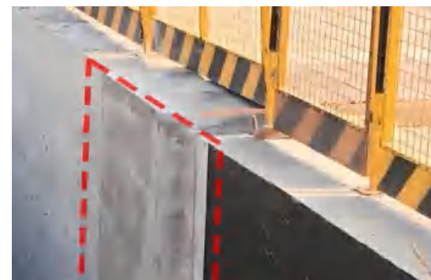
预制混凝土块超前止水完成实物图
