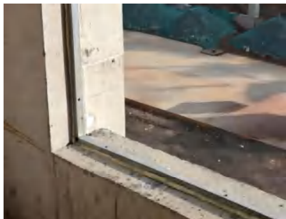
下口间隙采用发泡聚氨酯灌缝
