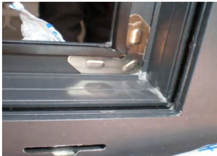
缝隙用硅酮耐候密封胶密封
