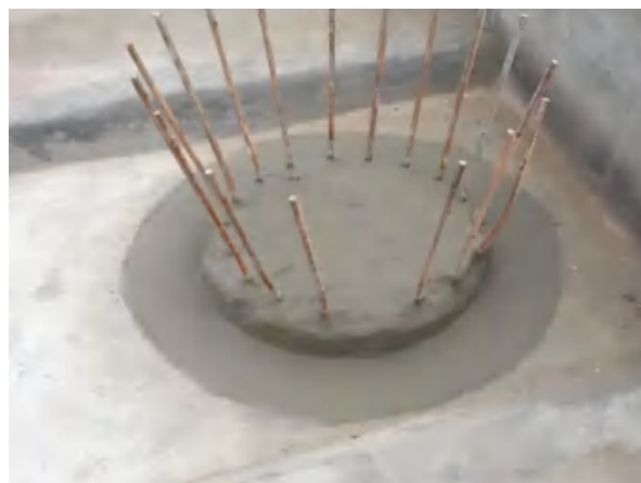
涂刷水泥渗透结晶防水涂料
