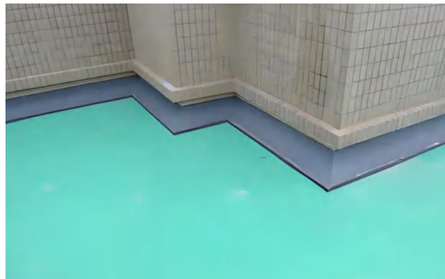
女儿墙泛水处水泥砂浆涂料保护
