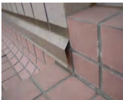
女儿墙泛水采用成品不锈钢压条
