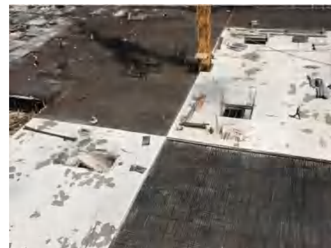
某地下车库基础底板跳仓法施工实景图
