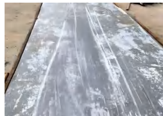
后浇带混凝土养护
