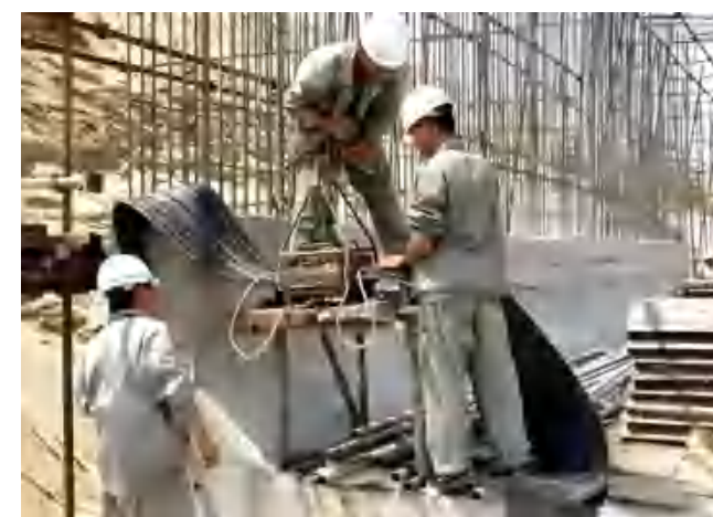
橡胶止水带热压焊接
