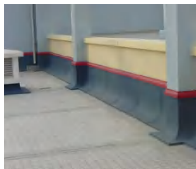
女儿墙泛水处水泥砂浆涂料保护
