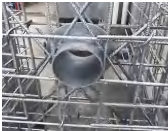
固定式穿墙管安装
