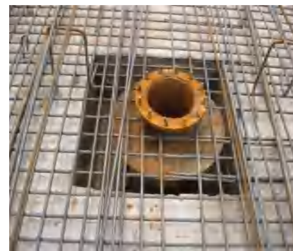
降水井穿越底板防水处理
