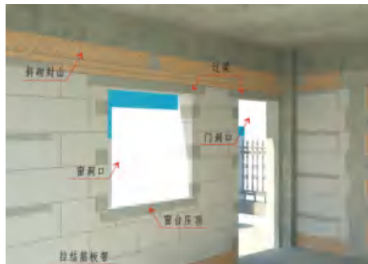
砌体墙窗洞下口设混凝土窗台压顶
