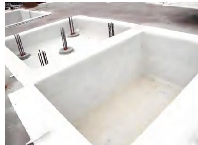
底板预铺反粘防水卷材施工
