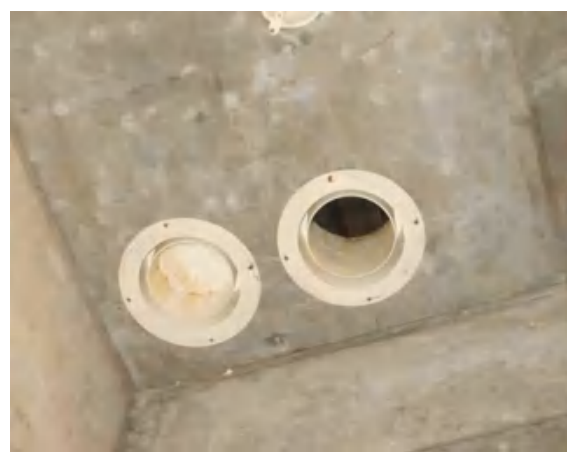
止水节安装成型效果
