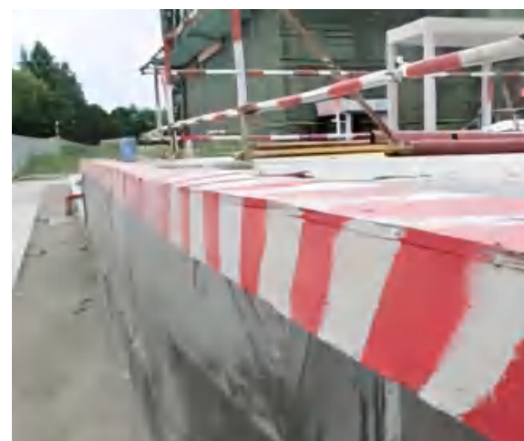
车库顶板阳角处防水保护
