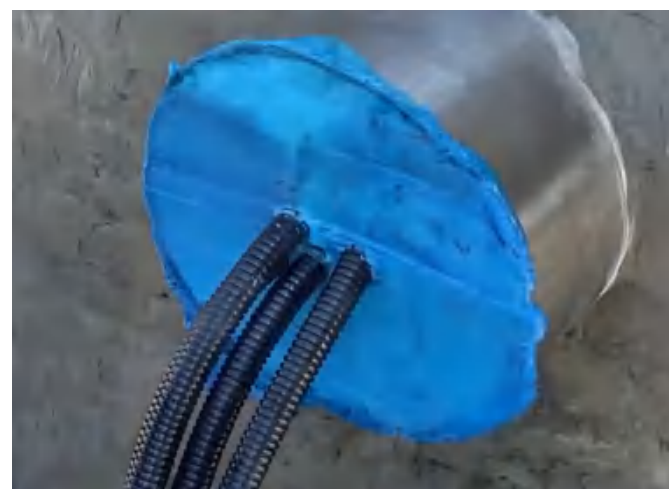
线缆穿管封堵
