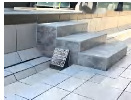
屋面水平出入口实物图
