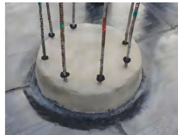
桩头根部防水密封处理
