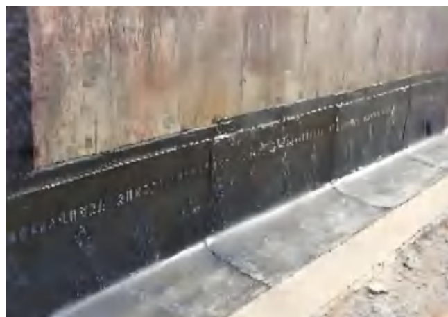
基层阴角防水加强层铺贴
