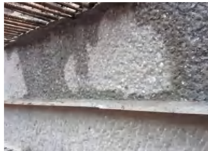
后浇带混凝土两侧凿毛
