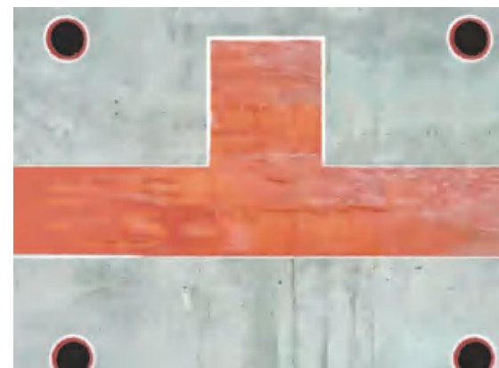
室外新旧混凝土接缝处涂刷防水涂料
