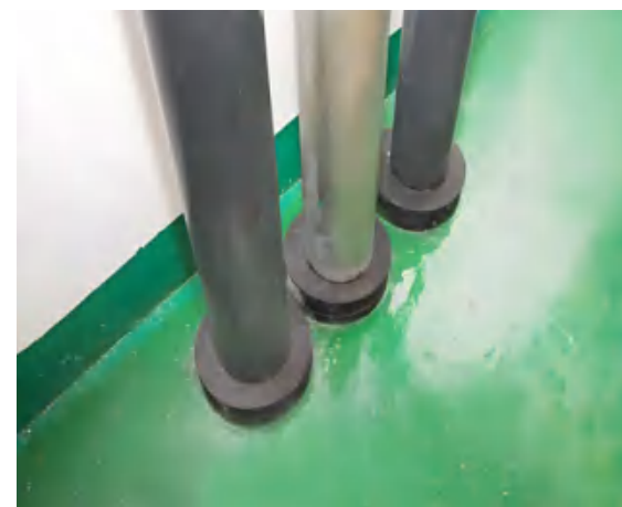
防水套管管道安装
