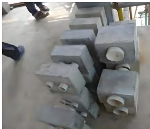
填充墙空调洞预制块
