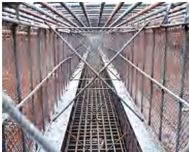
底板止水钢板安装示意图
