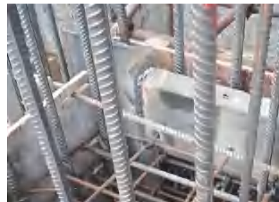
L 形止水钢板焊接
