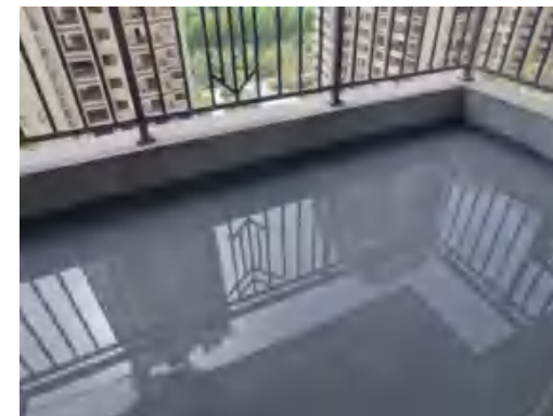
阳台闭水试验
