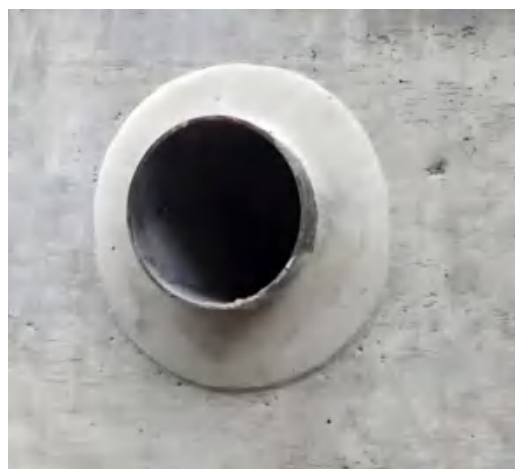
套管与管道之间的空隙密封处理
