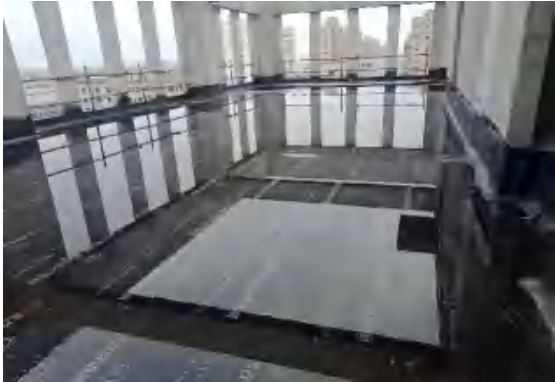
建筑屋面防水蓄水试验
