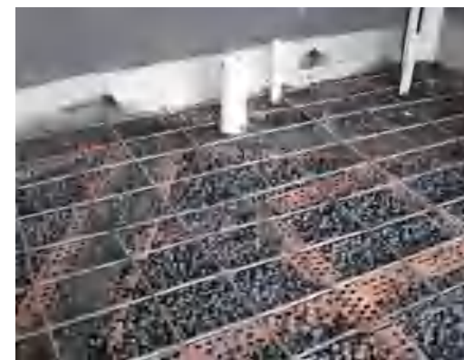
下沉式卫生间轻质填充层施工
