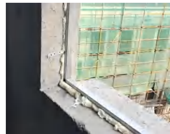
下口间隙采用发泡聚氨酯灌缝
