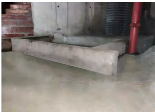
涉水房间混凝土坎台
