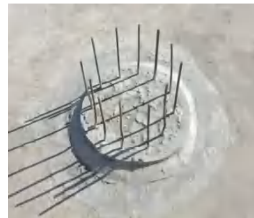
桩侧混凝土抹成圆弧状
