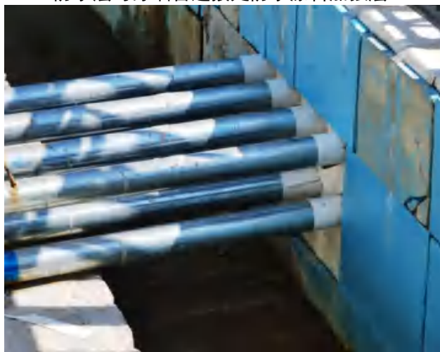
出墙管回填固定
