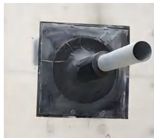
套管端口周边填塞密封胶
