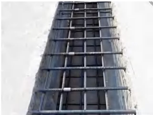
后浇带混凝土两侧凿毛
