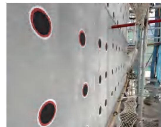
外墙螺栓孔封堵实物图
