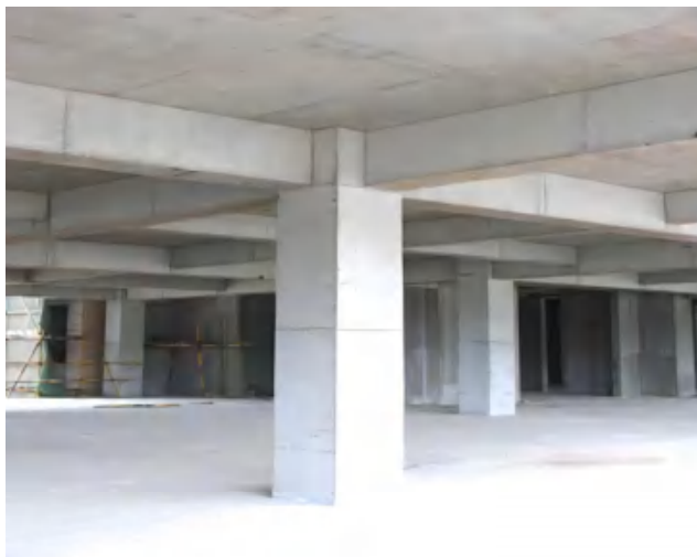
顶板现浇防水混凝土
