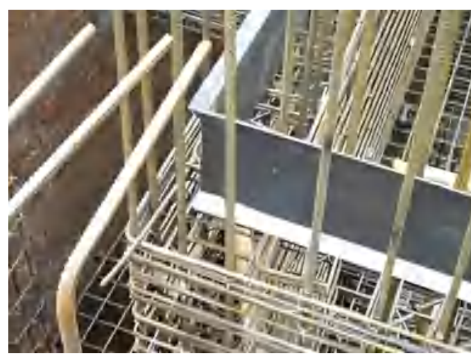
外墙转角处止水钢板安装
