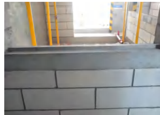
砌体墙窗洞下口设混凝土窗台压顶
