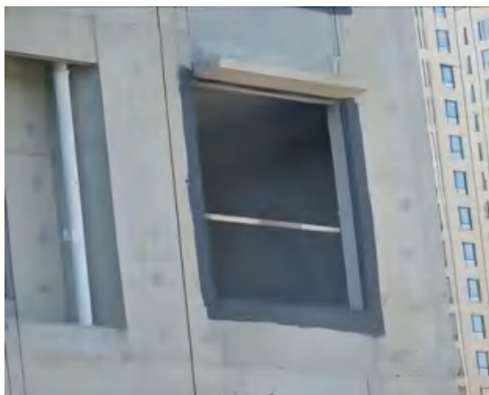
窗口周边防水涂料施工
