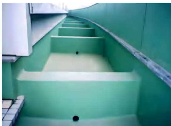
反梁过水孔实物图（一）
