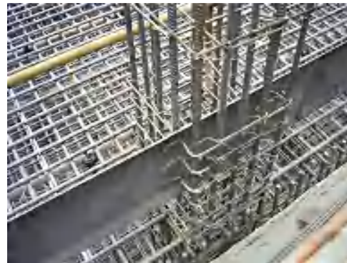
止水钢板穿柱部位箍筋加固方法
