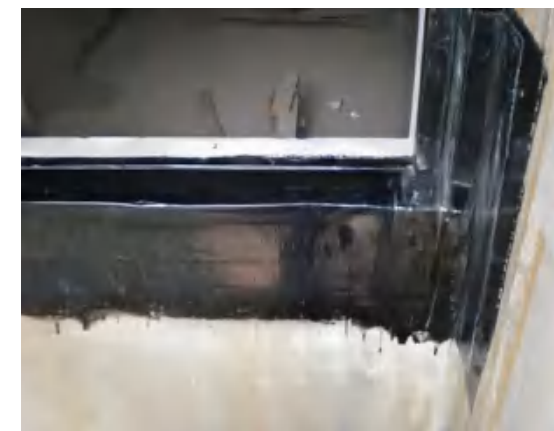
窗口周边防水涂料施工
