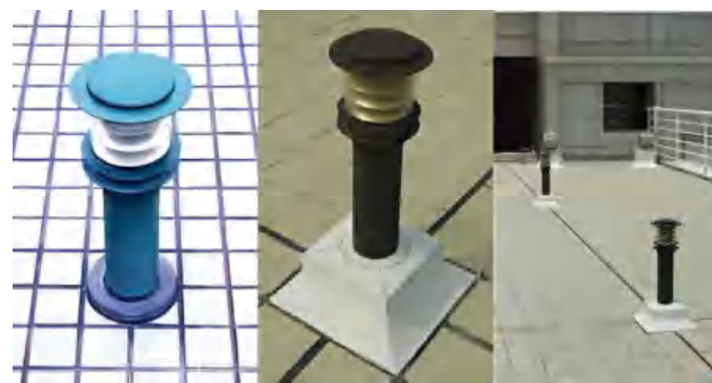
屋面排气管防水构造（不锈钢管）
