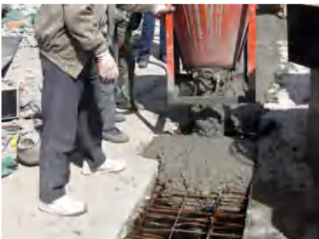
后浇带混凝土浇筑
