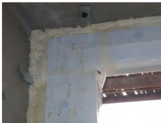
上口及侧口采用发泡聚氨酯灌缝
