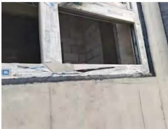
窗框与外墙交接处打胶处理
