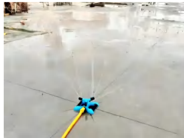
顶板混凝土浇水养护
