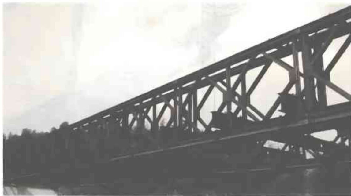
图 2-461 钢托架现场图片
