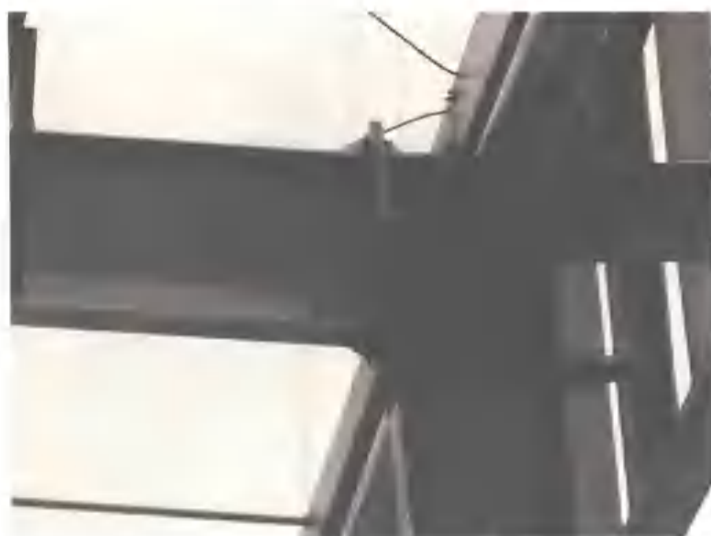
图 2-383 网架结构现场图片
