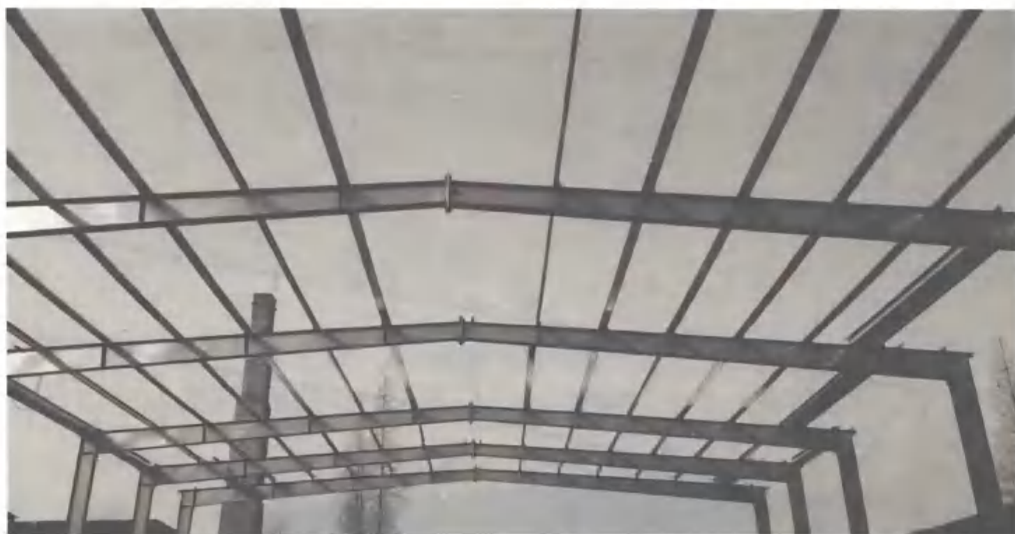
图 2-207 钢架现场图片
