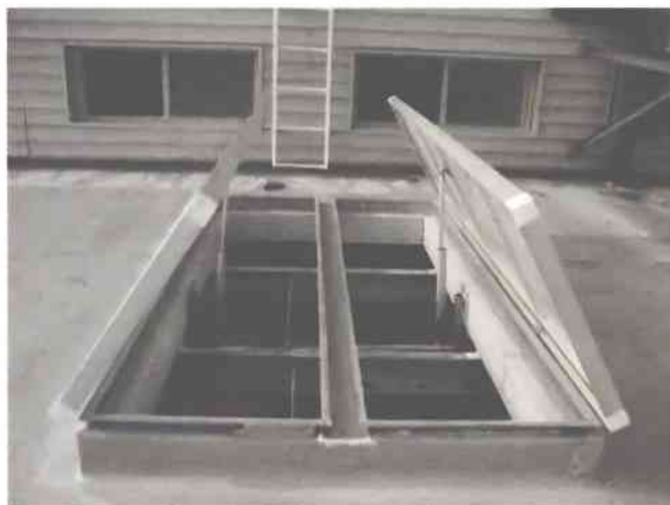
图 2-412 天窗架连接现场图片
