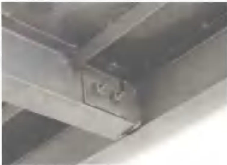
图 2-186 梁与梁连接节点现场图片
