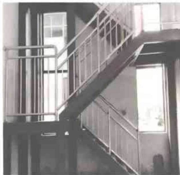
图 2-488 钢梯现场图片
