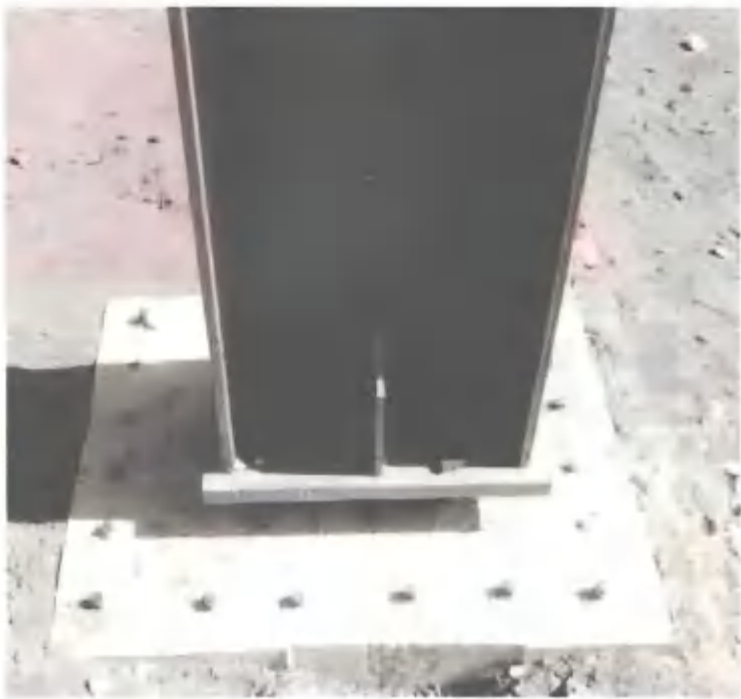
图 2-3 柱脚标准现场图片
