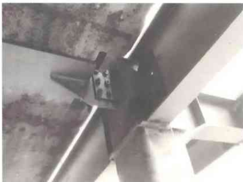
图 2-64 柱上节点现场图片
