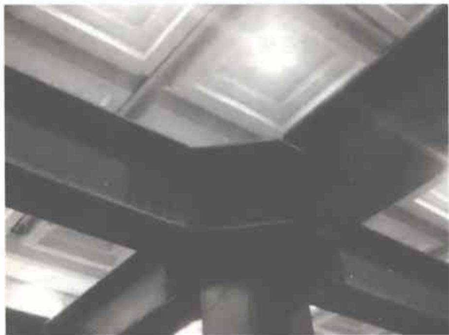
图 2-133 梁柱节点现场图片
