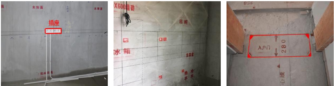
图 6-8：各种施工定位线示例
