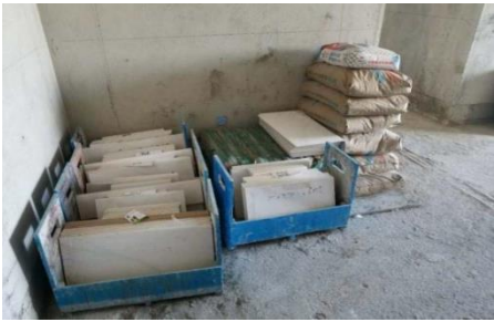
图 2：楼层现场堆放区
