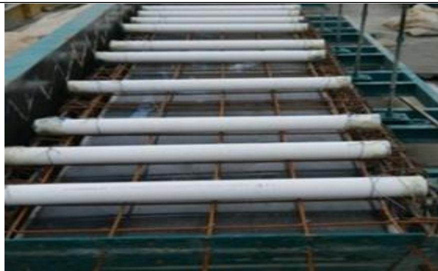
楼梯踏步抽芯减重
